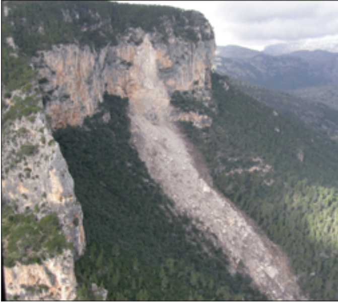
Figura 8. Avalancha de bloques sobre la ladera, con un alcance de 650 m y una anchura de la lengua de hasta 100 m. El bosque de pinar quedó completamente arrasado Figure 8. Rock avalanche with a length of 650 m and a tongue with up to 100 m in width. The pine wood was completely swept away
