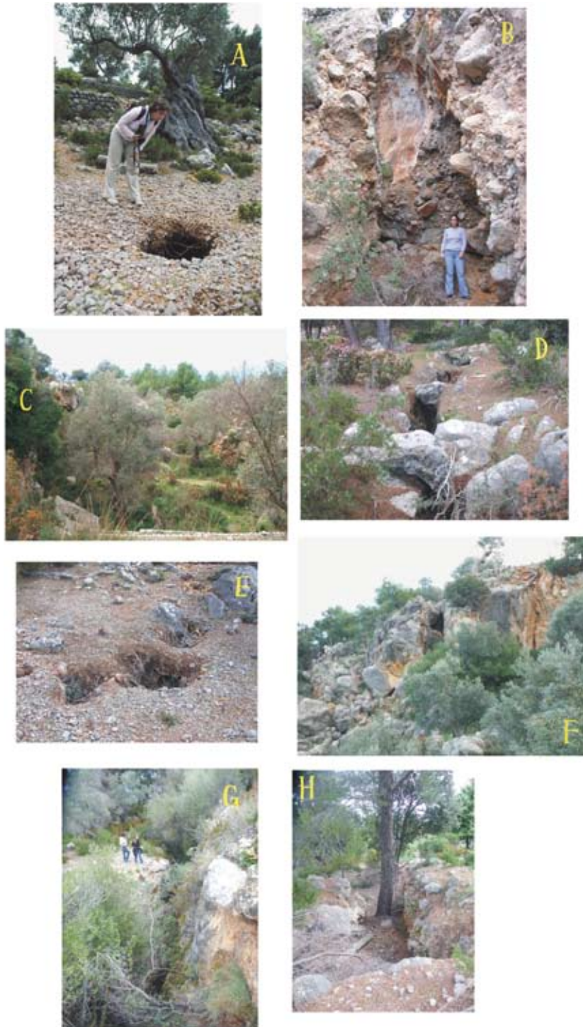
Figura 9. Apertura de grietas en los materiales del bloque deslizado. Presentan longitudes decamétricas, y algunas aperturas superiores a los 50 m (C). Se han cartografiado tanto en las brechas pleistocenas (B, C y H) como en las dolomías liásicas (D, F y G). La apertura de estas grietas son procesos activos que continúan en la actualidad, afectando al suelo y a los muros tradicionales de aterrazamiento (A, D, E).
