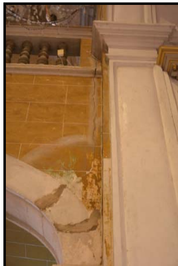
Fig. 97 – Detall de l'inici de l'esquerda, a la dreta de l'arc sota el Cor, en sentit de sortida del temple.
