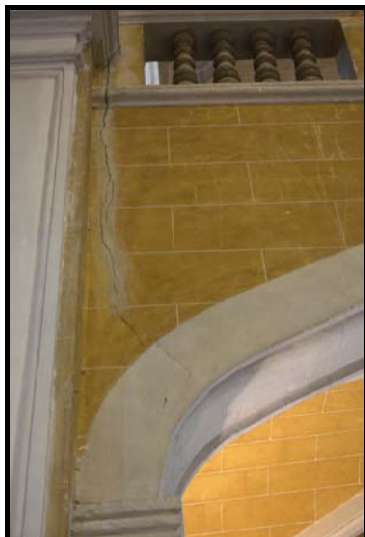
Fig. 96 – Detall de l'inici de l'esquerda, a l'esquerra de l'arc sota el Cor, en sentit de sortida del temple.
