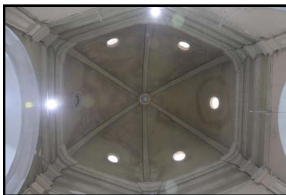
Fig. 52 - Vista interior de la cúpula de la Capella del Roser.
