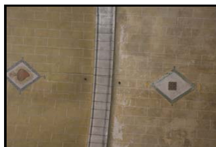
Fig. 107 – Detall de l'esquerda entre la cinquena i la sisena crugia.
