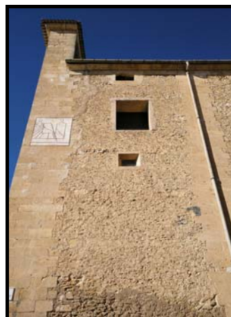
Fig. 58 – Vista de les parets de càrrega a la façana lateral
