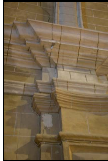
Fig. 99 – Detall de l'esquerda travessant les diferents cornises.
