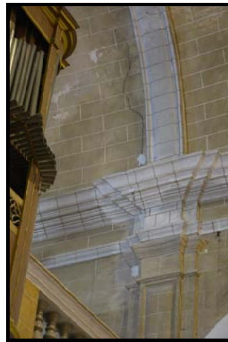
Fig. 101 – Detall de l'esquerda travessant les diferents cornises i afectant la volta de canó (costat dret en sentit de sortida).
