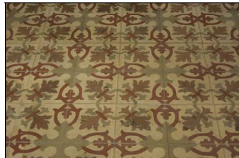
Fig. 68 - Paviment de la Capella de les Ànimes
