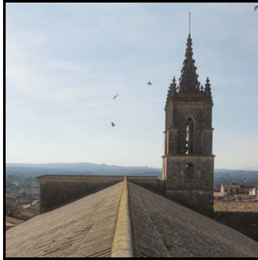
Fig. 25 - Vista posterior del campanar, des del carener.
