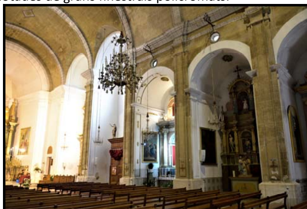
Fig. 36 - Vista interior on es pot apreciar els llanternons i la diferència dels arcs de les capelles antigues i les més recents.
