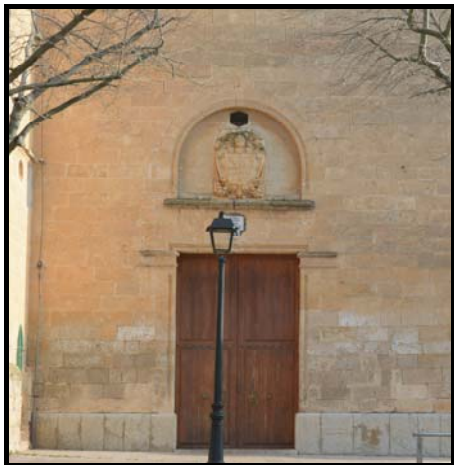
Fig. 63- Detall de la façana principal.
