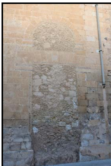
Fig. 27 - Detall de la façana lateral, antic accés lateral, ara tapiat.
