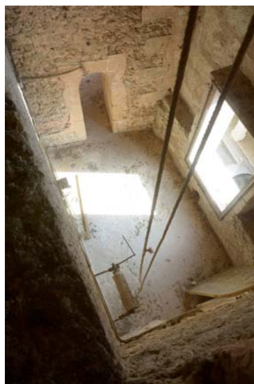
Fig. 31 - Vista del forjat del nivell galeries.
