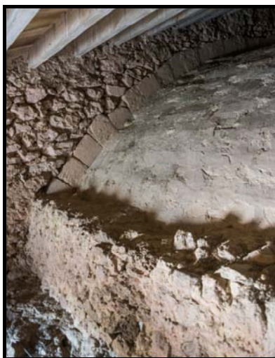
Fig. 59 - Vista de la vola de canó i el ronyó a sota coberta.
