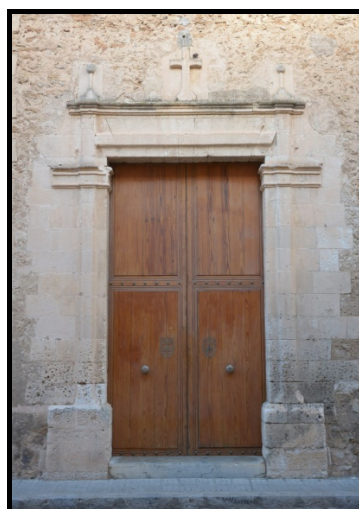
Fig. 18 - Entrada façana lateral
