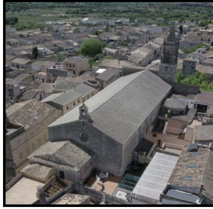
Fig. 60 - Vista aèria de la coberta, obtinguda amb el DRON.
