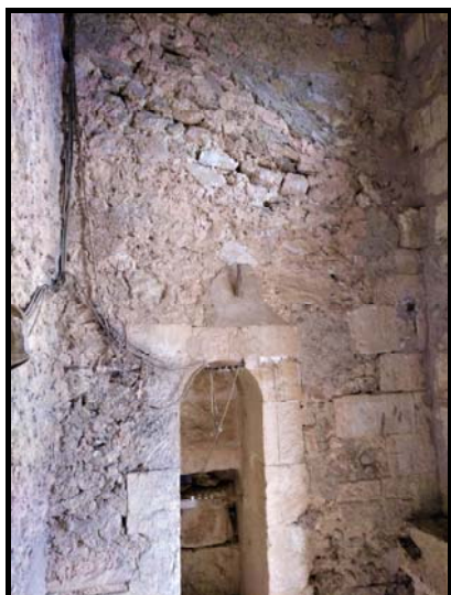
Fig. 30 - Vista interior d'una de les parets de càrrega.
