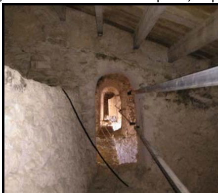
Fig. 32 - Vista del passadís al nivell sota coberta.
