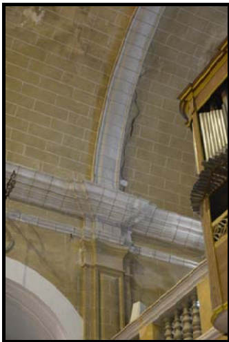
Fig. 100 – Detall de l'esquerda travessant les diferents cornises i afectant la volta de canó (costat esquerra en sentit de sortida).
