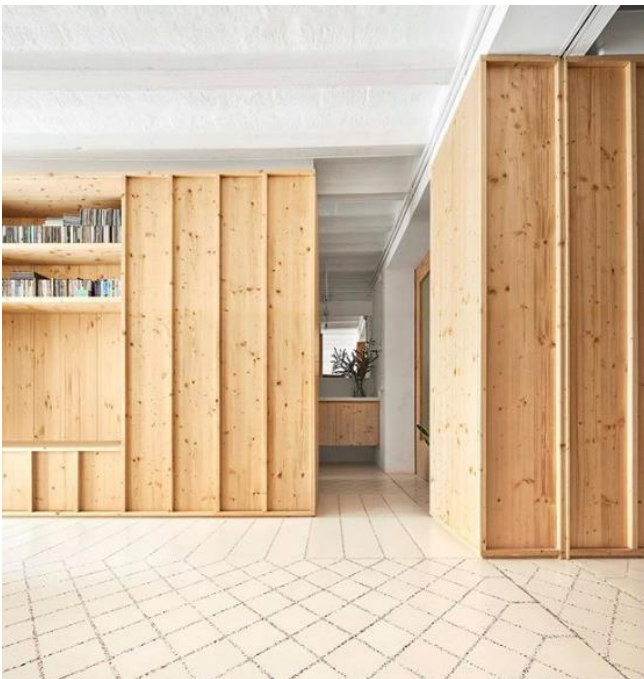
Trespòl de rajoles hidràuliques (Imatge: TED'A Arquitectes)
