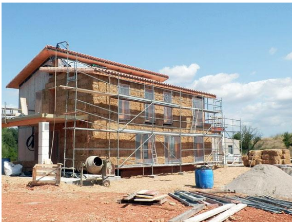
Vivienda unifamiliar de palla en Inca
