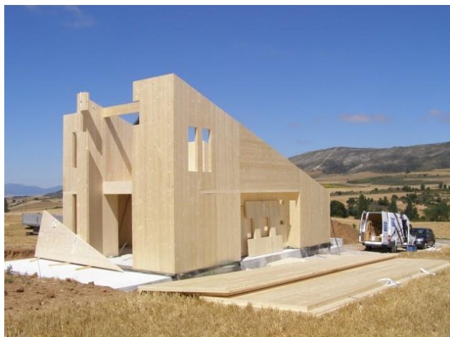
Vivenda unifamiliar amb estructura KLH (imatge: www.biohaus.es )
