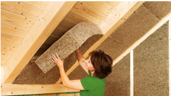
Aïllament de fibra de fusta en paraments verticals i cobertes (imatge:www.archiproducts.com)
