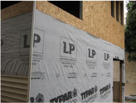
Làmina impermeable transpirable (Imatge: http://rcpisos.com.br/produto/membrana-lp-brasil/ )
