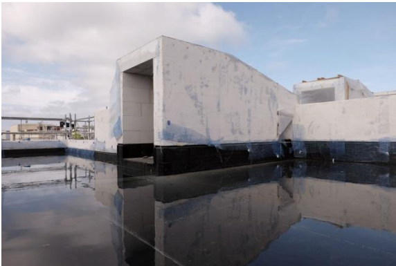
Coberta impermeabilitzada amb EPDM (Imatge: IBAVI)
