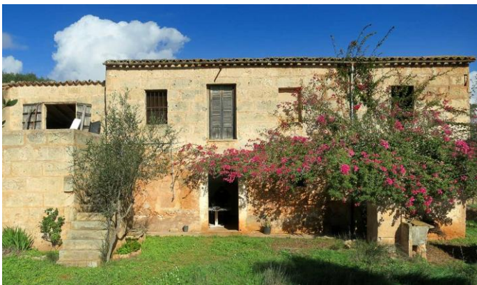
Vivenda unifamiliar marès (Imatge: http://construirunacasaecologica.com )
