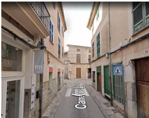
Figura 14. Estació nº 38. Canó urbà al carrer de sa Rectoria. Font Google earth
