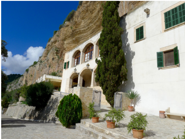
Fotografía: Elaboración propia
