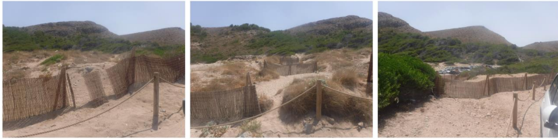
Figura 6. Situació de les trapes d'interferència eòlica al sistema platja-duna de Cala Torta. Elaboració pròpia.
