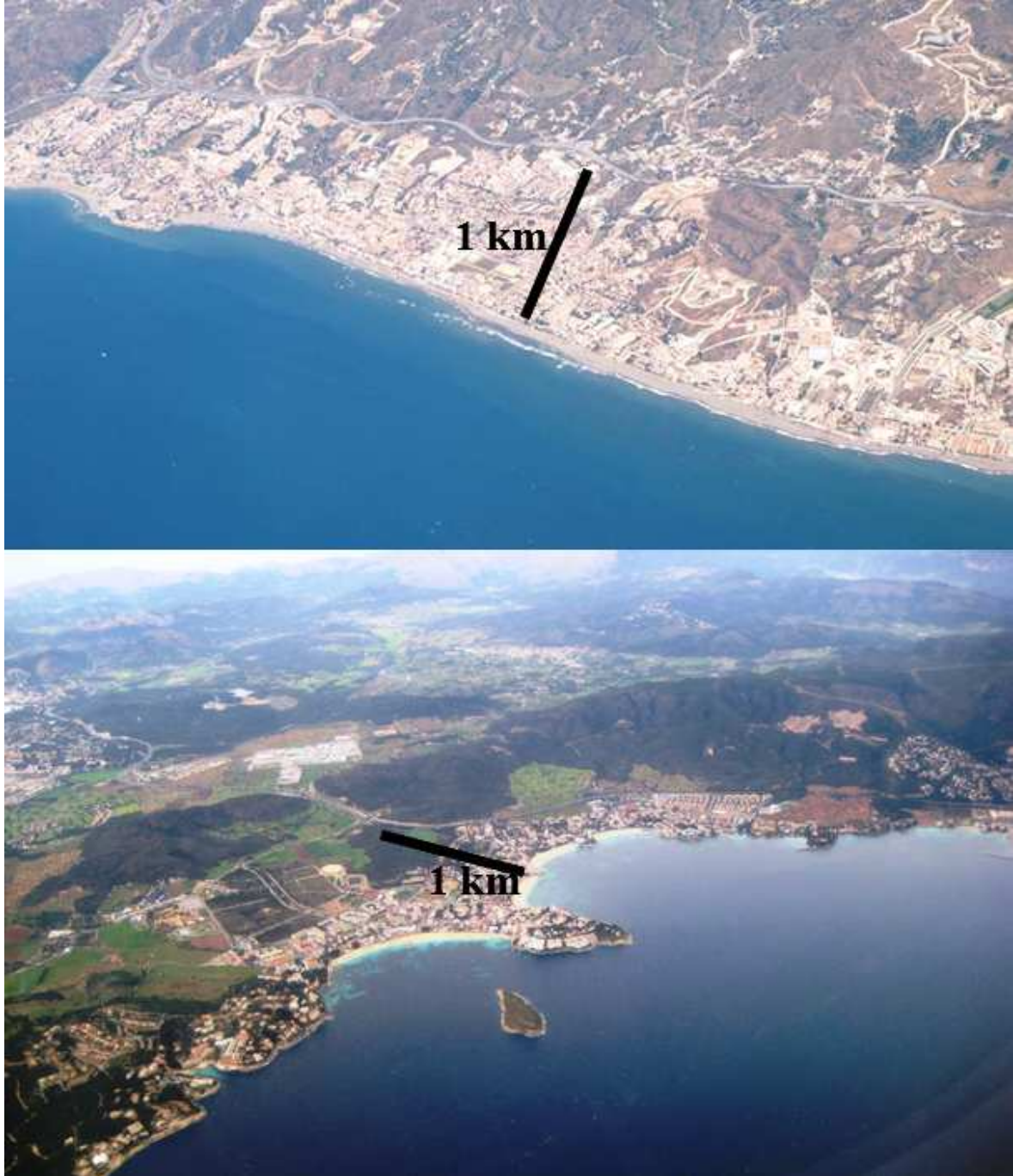
Fig. 16. Cobertura de sòl artificial en la franja del 1r Km de costa, a Costa del Sol (Màlaga) i Magaluf (Calvià, Mallorca) al 2011. Font: Els autors de les fotografies, preses per Antoni A. Artigues (superior) i Onofre Rullan (inferior).
