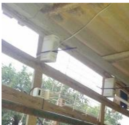
Imatge 4: En aquesta imatge es poden veure els dos altaveus, dirigits a l'interior de l'estable, just a sota dels altaveus podem veure el programador digital.
