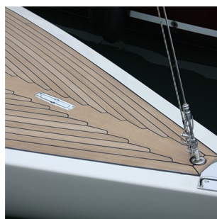
Coberta de teca calafatada
