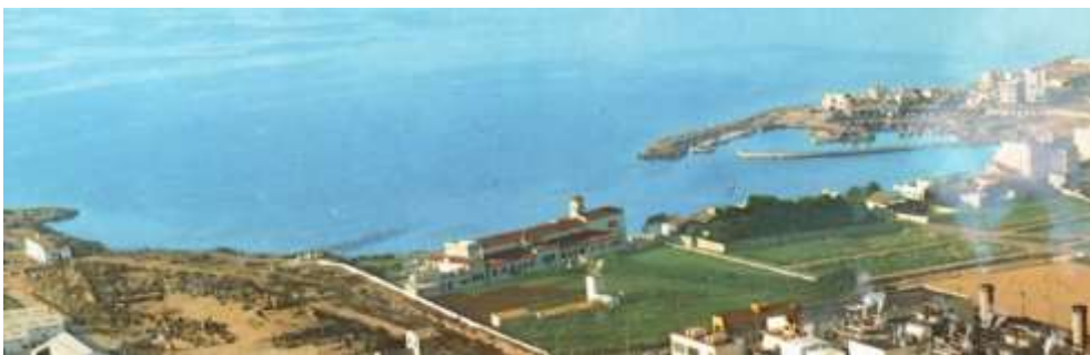
Imagen superior y central: panorámicas de la fachada marítima del sanatorio apreciando el edificio general, la capilla, el edificio anexo para usos domésticos, la pista de básquet, la piscina terapéutica, el jardín terapéutico y el frontón. Imagen inferior: panorámica de la fachada posterior del sanatorio con el molino y la granja en primer término; anexo para usos domésticos, la pista de básquet, la piscina terapéutica, el jardín terapéutico y el frontón. Fuente: archivo histórico del HSJD de Palma de Mallorca y gentileza de P. Galiana Veiret
