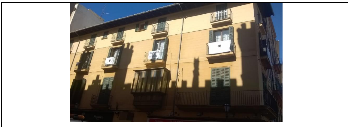
Figura 140. Edificio de viviendas en plaza Cort
