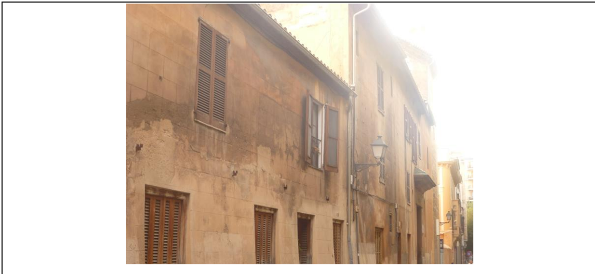
Figura 79. Casa del capellán del convento de Santa Teresa
