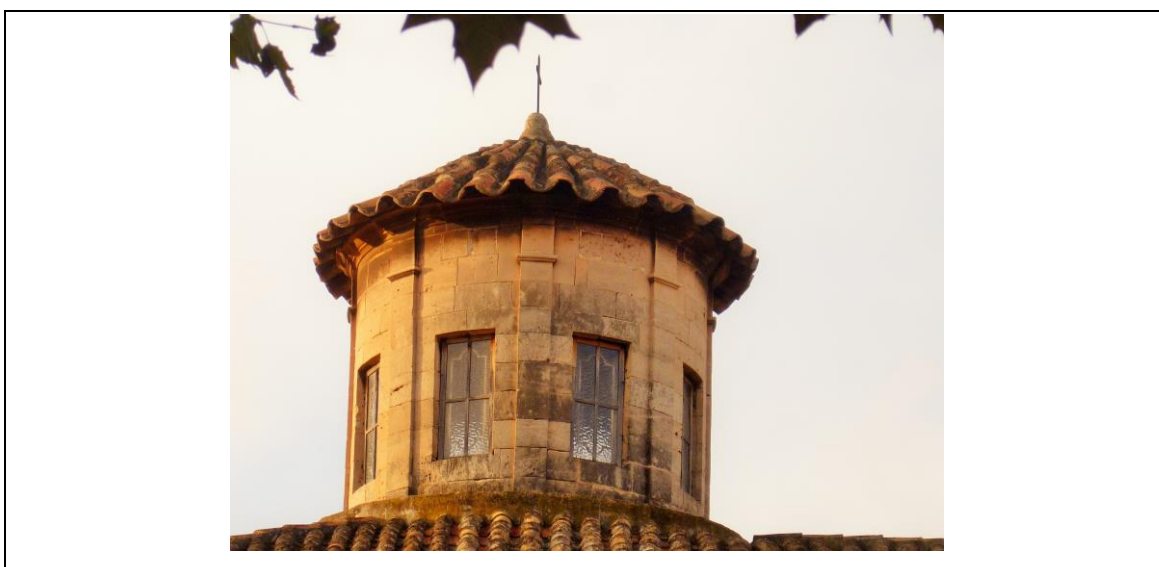
Figura 109. Linterna que corona la cúpula de la iglesia de Santa Magdalena
