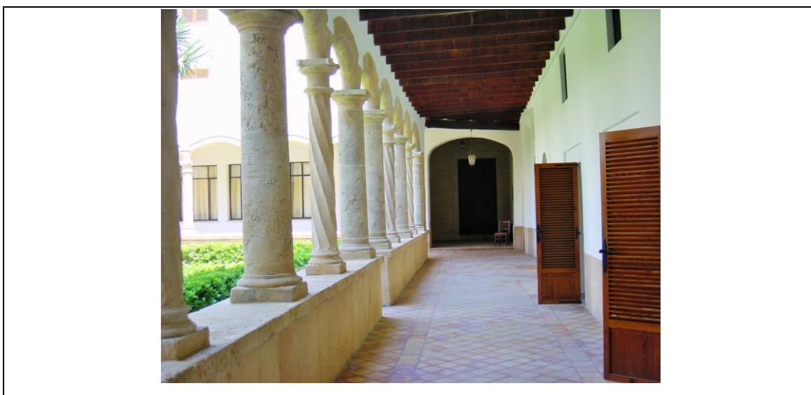
Figura 112. Claustro del convento de la Concepción
