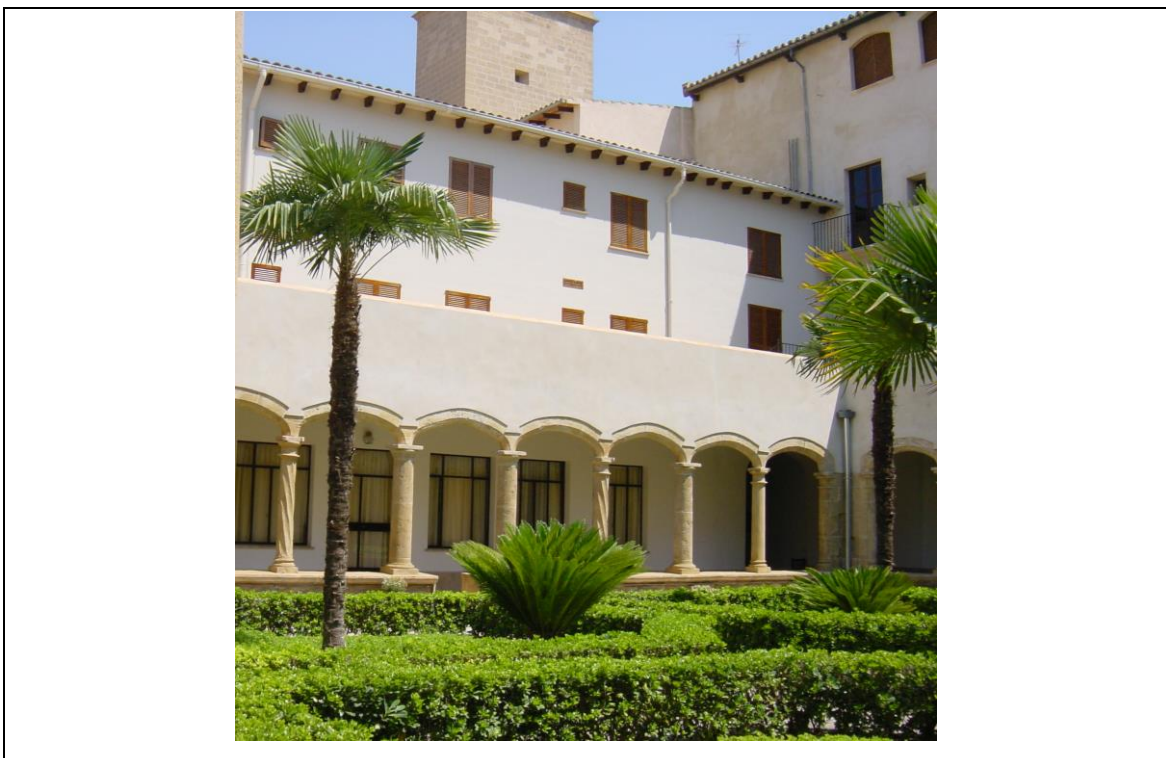
Figura 96. Claustro del convento de la Concepción
