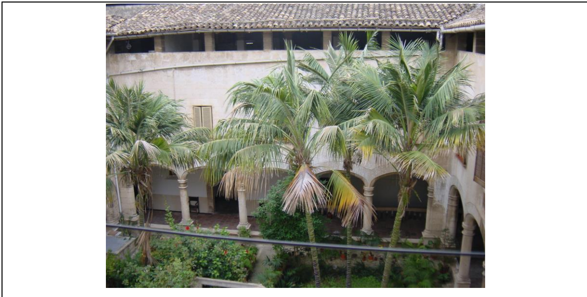
Figura 125. Claustro del convento de Santa Teresa
