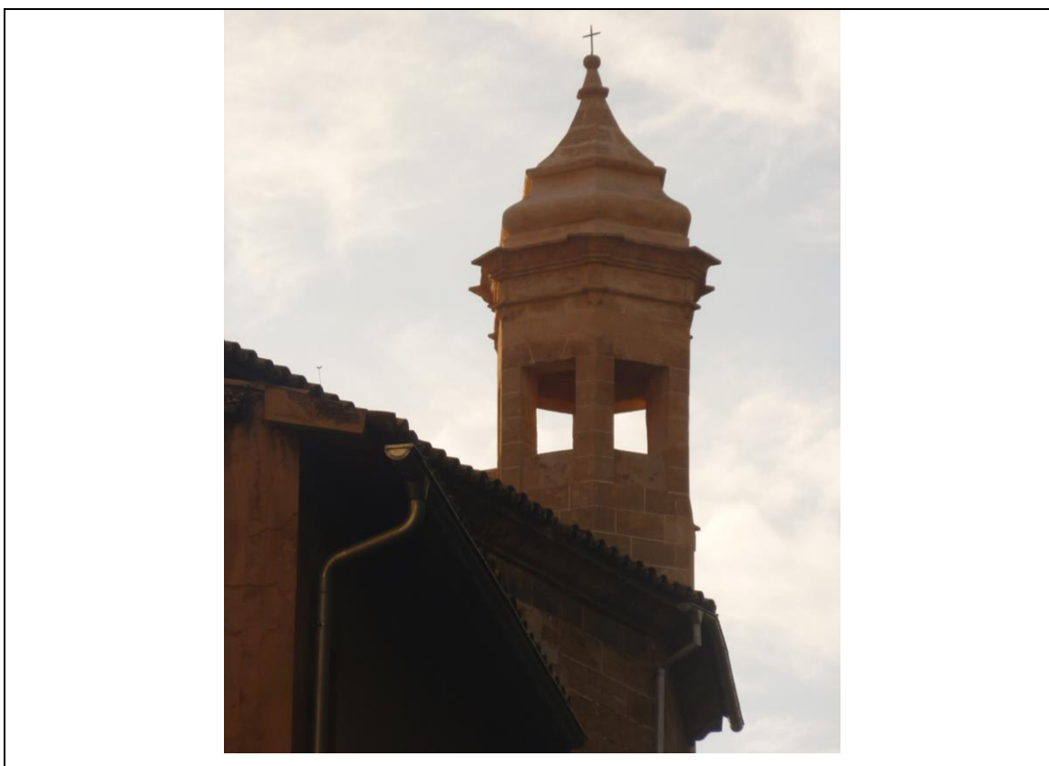
Figura 15. Torre de la Iglesia de Santa Teresa
