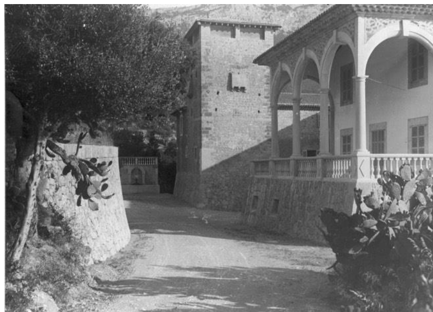
Figura 311. "Porxo, torre i camí de Son Marroig". Entre 1890 i 1936 (catalogador). Arxiu Fotogràfic Centre Excursionista de Catalunya.
