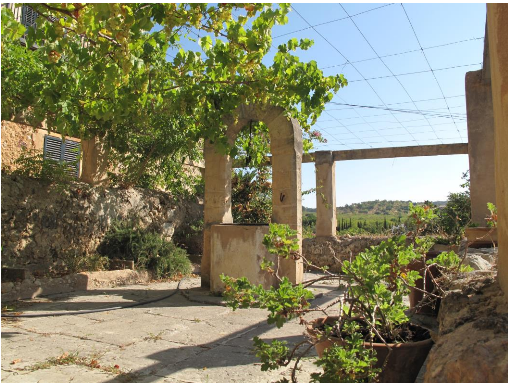
Figura 327. Coberta de l'aljub.
