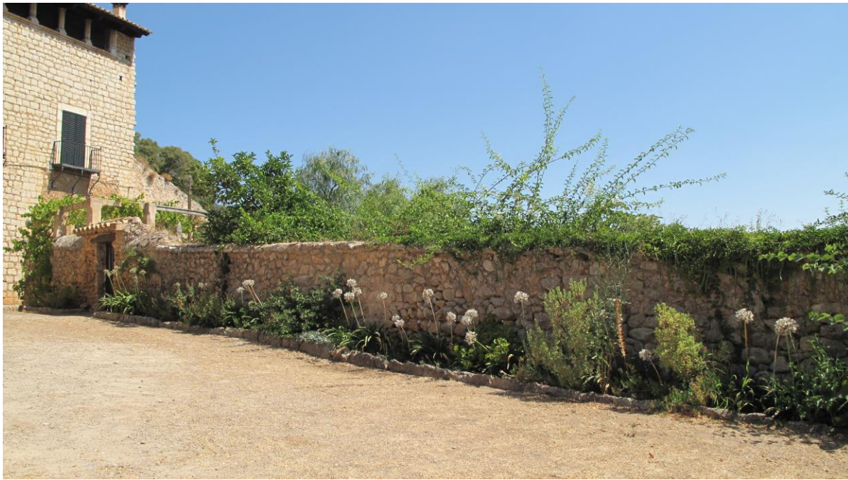
Figura 322. Mur de tancament occidental i accessos del jardí.
