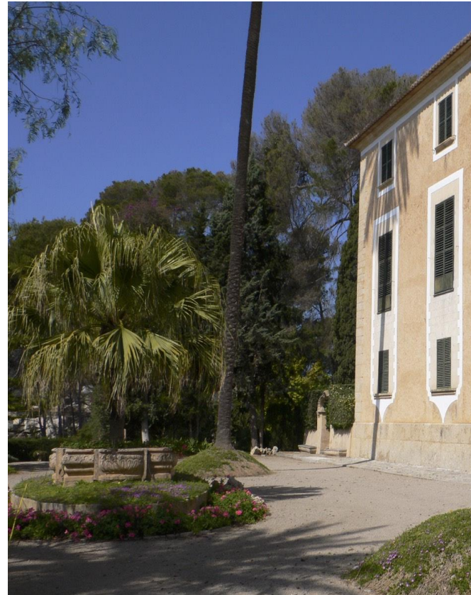
Figura 177. Façana de Son Berga. Estat actual.
