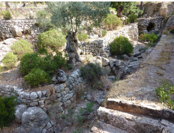
Figura 188. Canalització de l'aigua de les fonts a partir d'un torrentó i el recorregut amb sèquies i canals per diferents zones del bosc i camps marjats.
