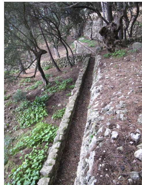
Figura 188. Canalització de l'aigua de les fonts a partir d'un torrentó i el recorregut amb sèquies i canals per diferents zones del bosc i camps marjats.
