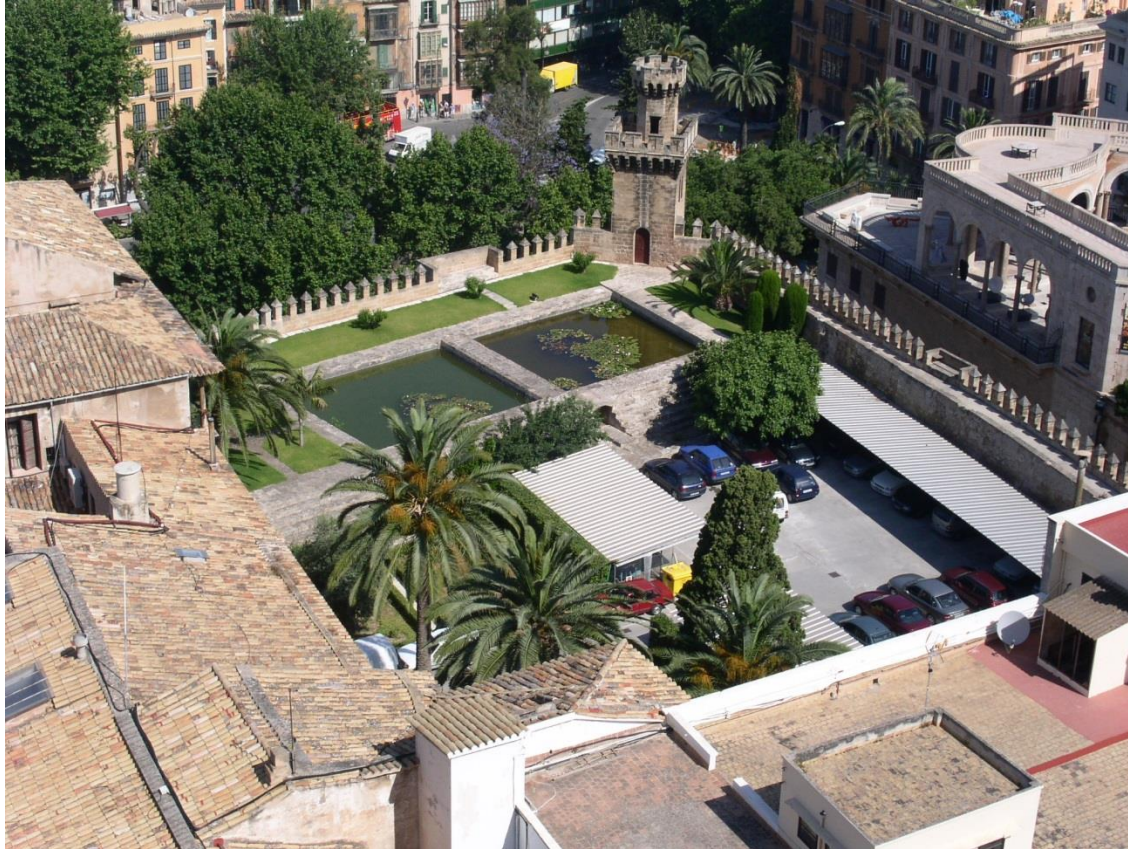
Figura 24. Palau de l'Almuḍaina. Estat actual del pati nord del recinte.
