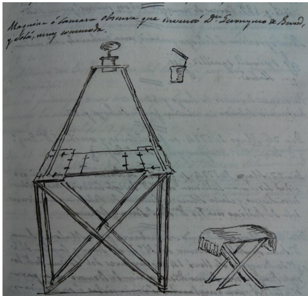
Figura 49. Càmera obscura de Geroni de Berard. Bonaventura Serra, Memorias y anotaciones (1774). BPP, Ms-614, f. 52..
