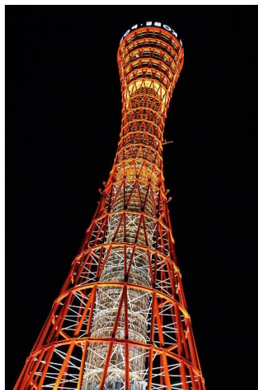
Fig.3 Hiperboloide a un edifici del port de Kobe.
