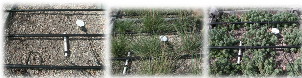
Figura 3.9 Módulos con sensores ambientales instalados (experimento 3).
