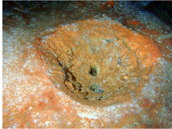
Figura 7.1.50: Caldera a la galeria Jaume Damians. (Foto F. Gràcia).
