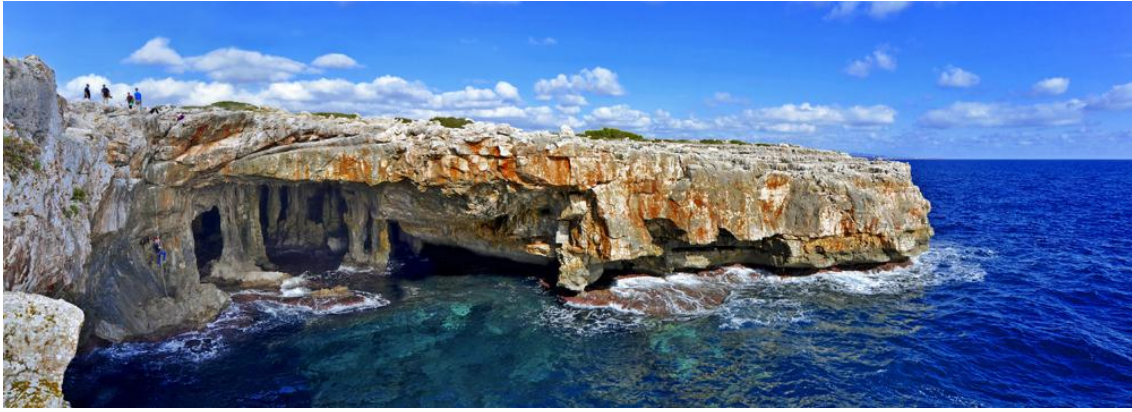
Figura 17.4: Cova del Pilar, a la marina de Manacor. El progressiu desmantellament de la cavitat genera una entrada de la mar terra endins (Foto: M. A. Perelló. GNM).
