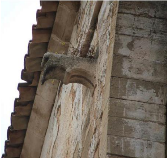
Fig. 190.- Gárgola de la iglesia de Petra
