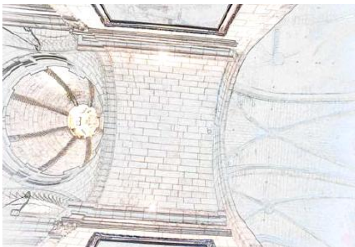
Fig. 187.- Detalle plementería realizada con recortes.
