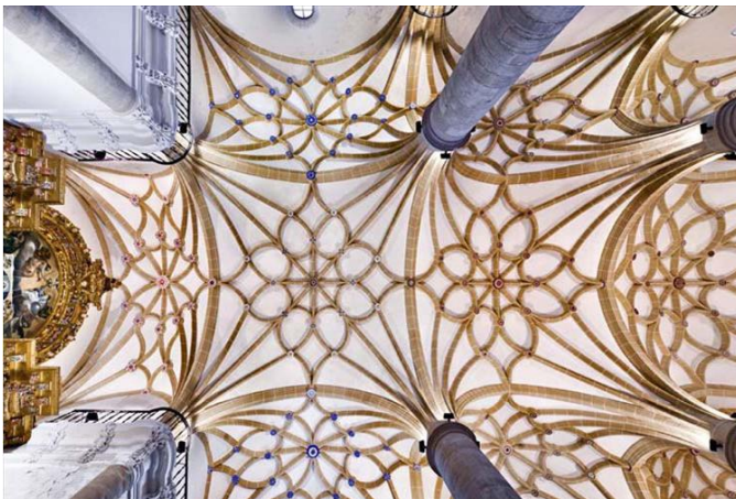
Fig. 8.- Vista general de la bóveda de la Iglesia de Garcinarro.
