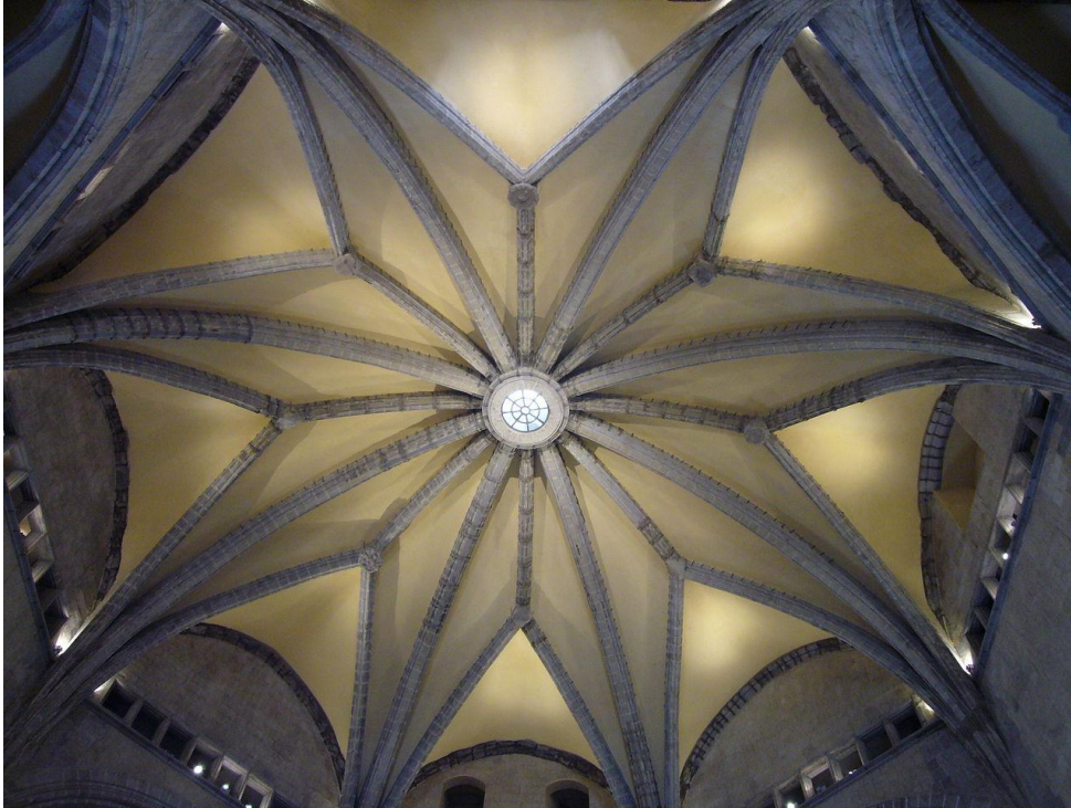
Fig. 73.- Bóveda de crucería estrellada, Sala dei Baroni, Castel Nuovo.
