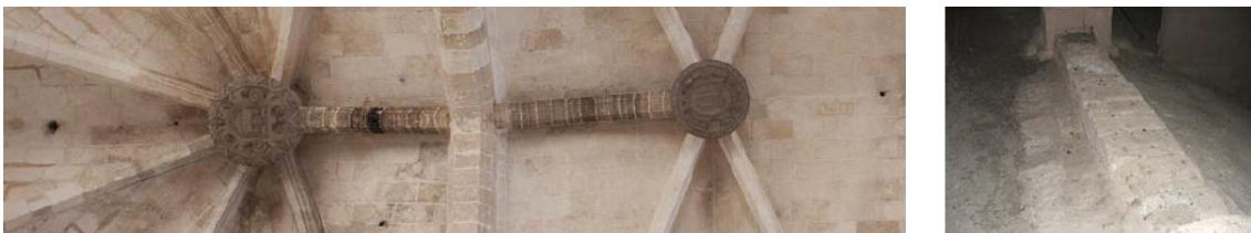
Fig. 184.- Nérvio de ligadura de la iglesia de Artà. Vista desde el intradós y el extradós de la bóveda
