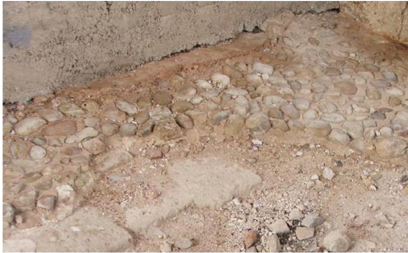
Fig. 189.- " Terrades " sobre las capillas de la iglesia de Muro
