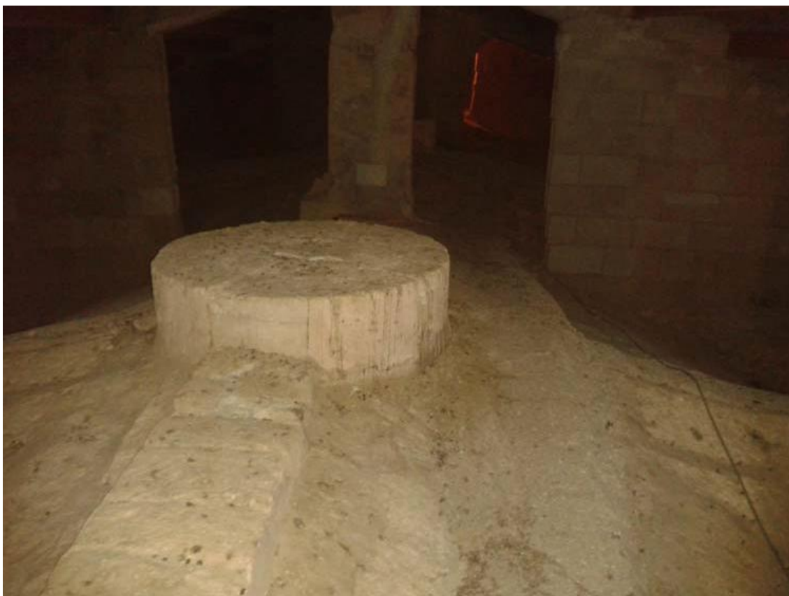
Fig. 179.- Extradós de la bóveda de la iglesia de Artà. Clave del segundo tramo.
