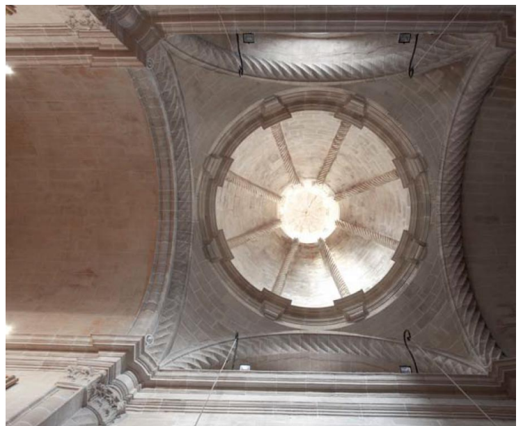
Fig. 154.- Vista cenital de la cúpula octogonal
