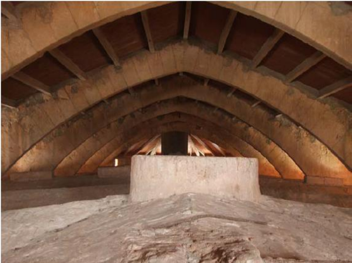
Fig. 116.- Vista del espacio entre cubiertas
