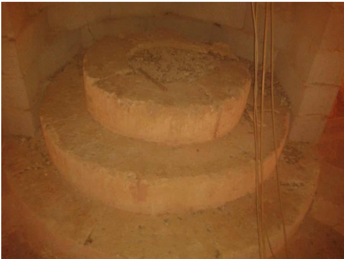
Fig. 178.- Grandes sillares sobre la clave del ábside de la iglesia de Muro.
