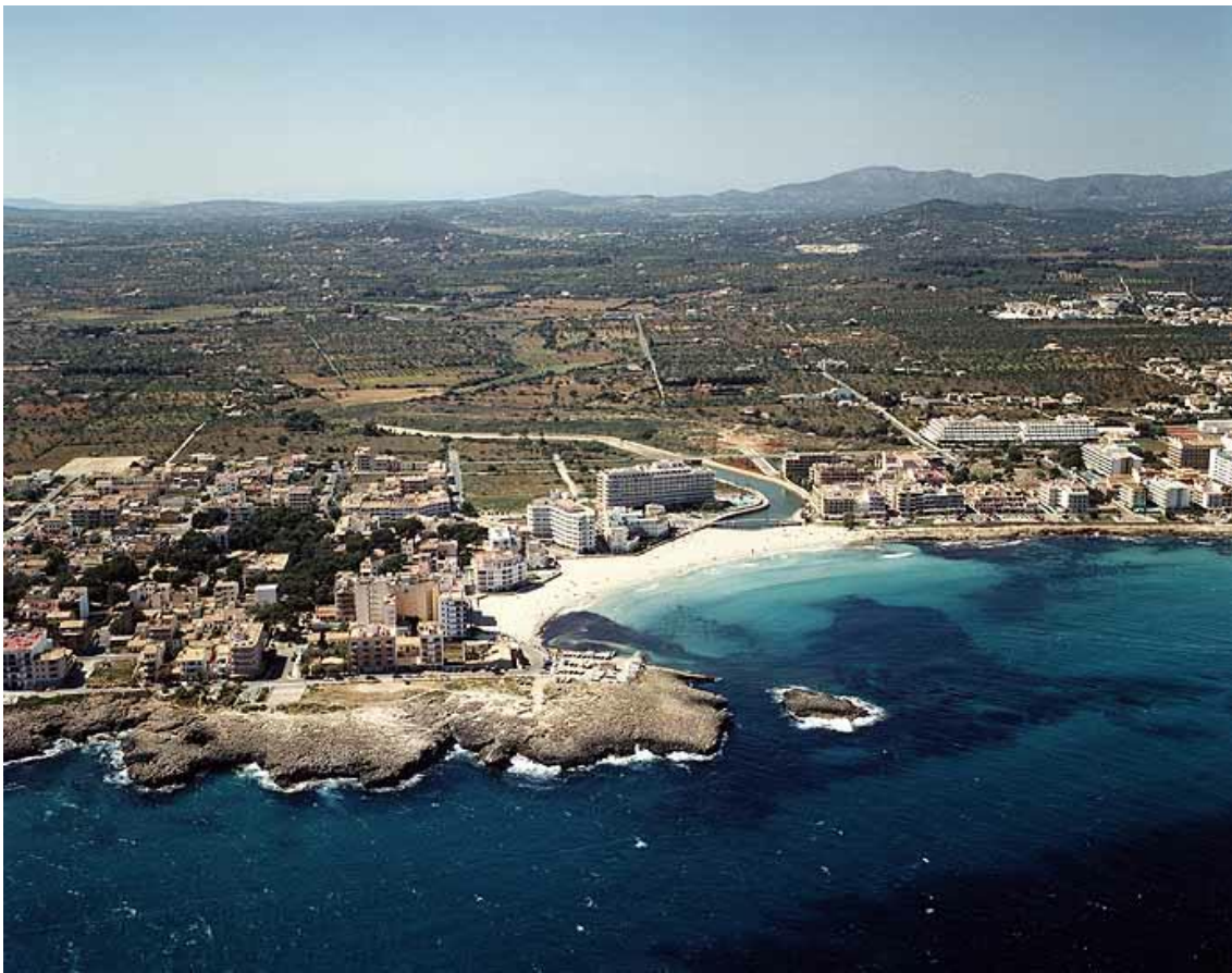
Figura 5.31: Foto Aérea de s'Illot (fuente: SOCIB <Sistema de Observación y Predicción Costero de las Illes Balears>, Conselleria de Medio Ambiente del Govern de les Illes Balears).
