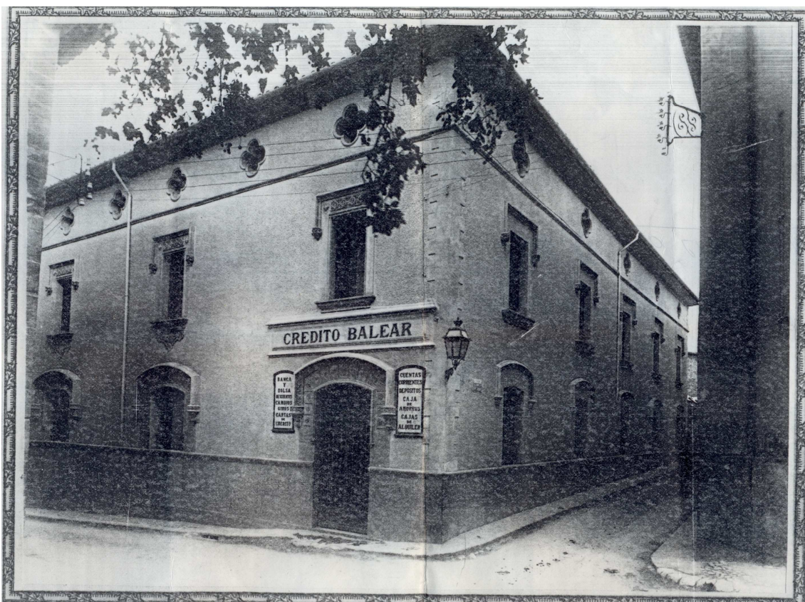
Edifici del Banc de Crèdit Balear el 1920 (arxiu Miquel Colom)
