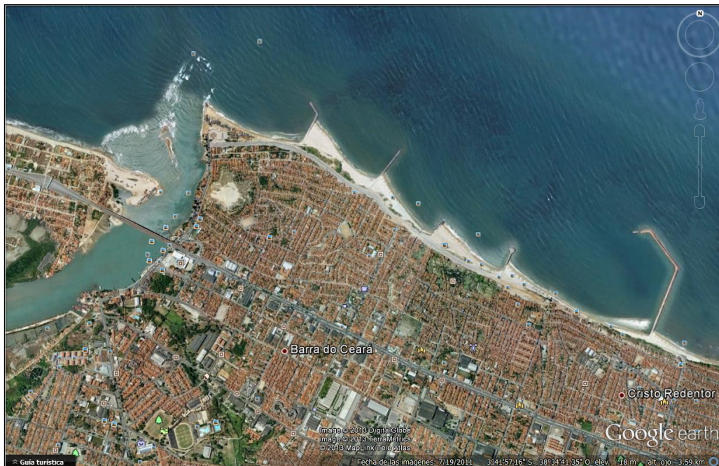
Figura 39 - Detalle del efecto de la construcción de espigones y diques en la redistribución del sedimento de las playas de la Avenida Costa Oeste (desembocadura del Río Ceará). Fortaleza.
