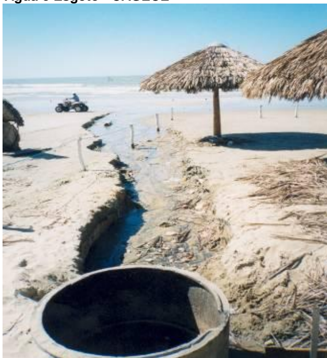
Figura 56 - Playa de Lagoinha – Paraipaba. Delante la Estación de la Companhia de Abastecimento de Agua e Esgoto - CAGECE
