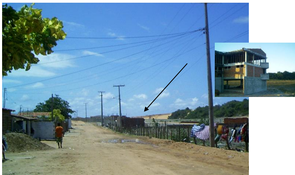
Figura 80 - APA de las Dunas de Lagoinha a la Derecha con la Construcción del Resort y a la Izquierda, Fuera del APA la Población Local. Paraipaba – Ceará
