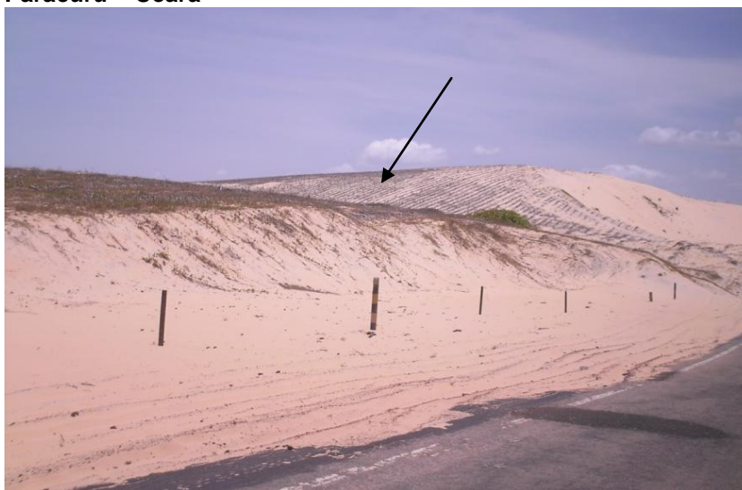
Figura 75 - Contención de Dunas con Vegetación Sembrada. Paracuru – Ceará
