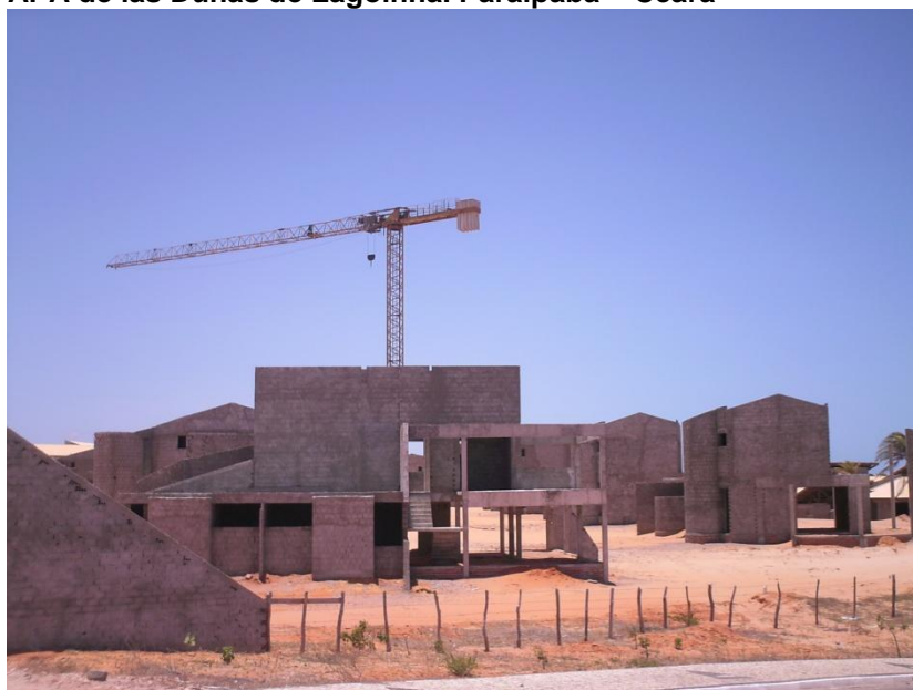
Figura 65 - Construcción del Vivamar Resort Village Hotel en el APA de las Dunas de Lagoinha. Paraipaba – Ceará
