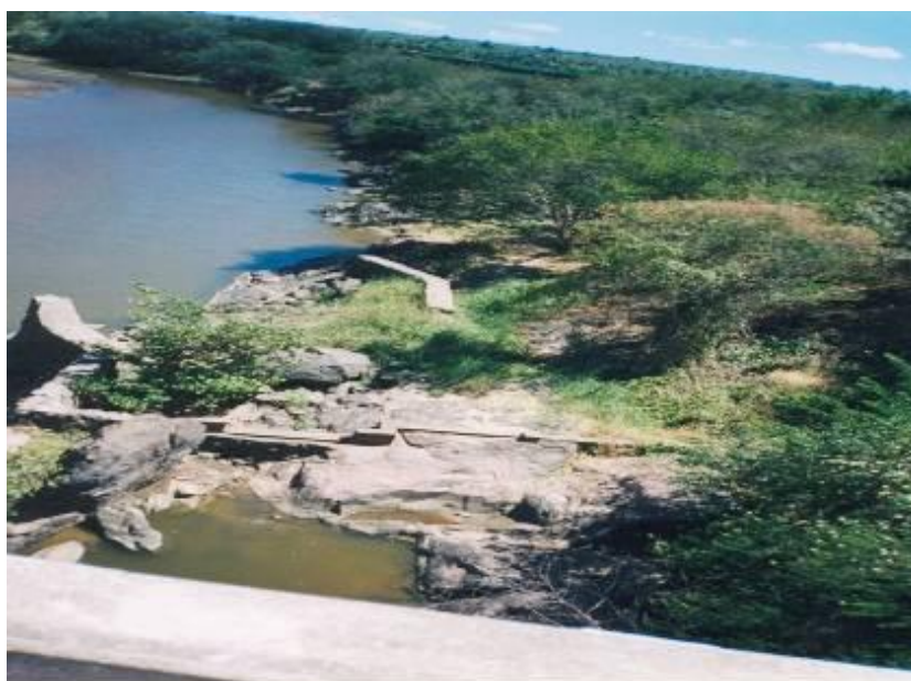
Figura 53 - Río Curu, Sistema de Captación de Agua por Acueducto. Tramo de la Autopista CE-085 - Paraipaba
