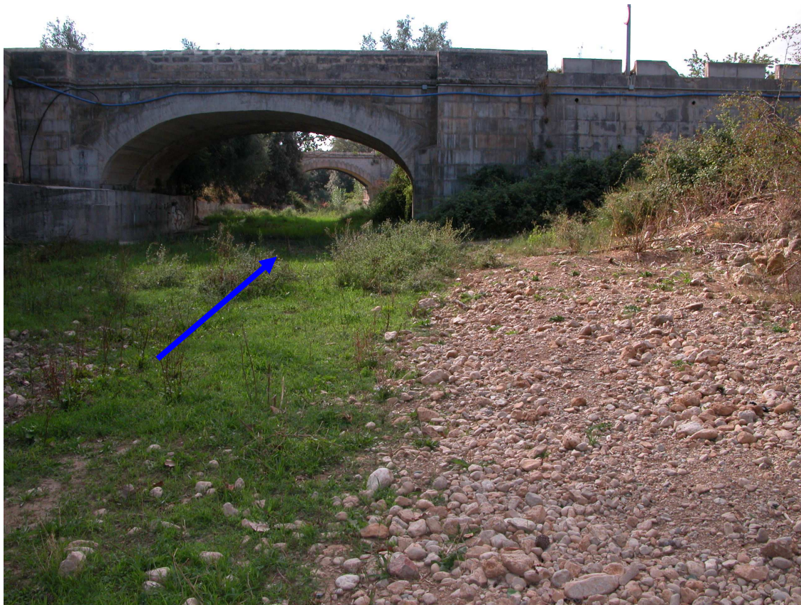
Figura 82: Ponts al torrent d'Almadrà
