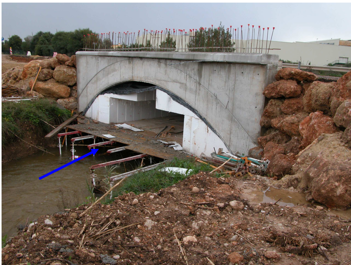
Figura 34: Pont a la carretera Camp d'Inca- Bunyola (Ma-2040)
