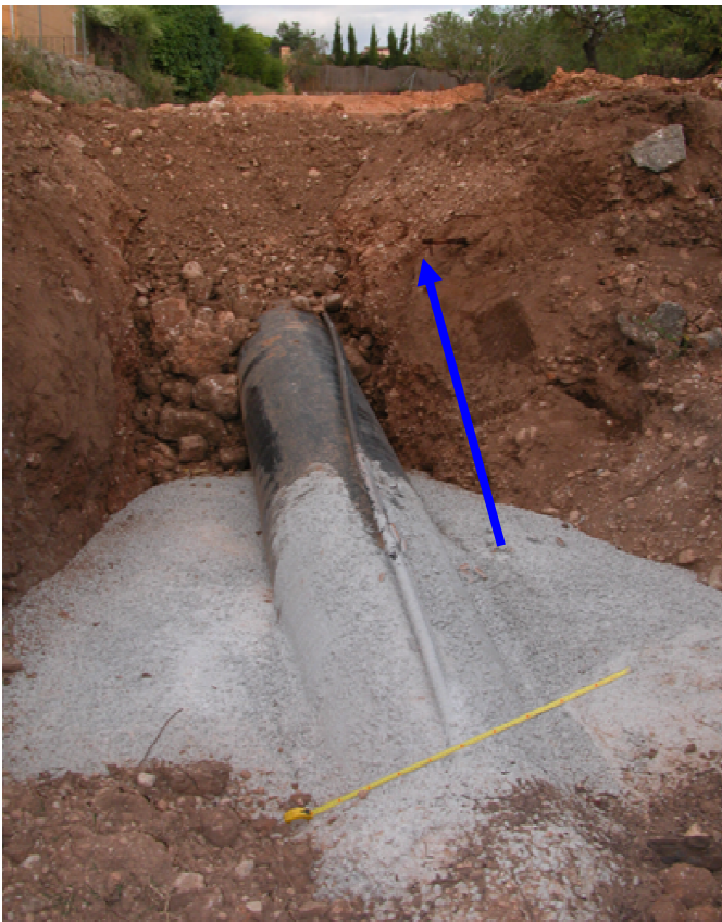
Detall de les canalitzacions a Coanegra. Juny de 2008 (Escala 1 metre)
