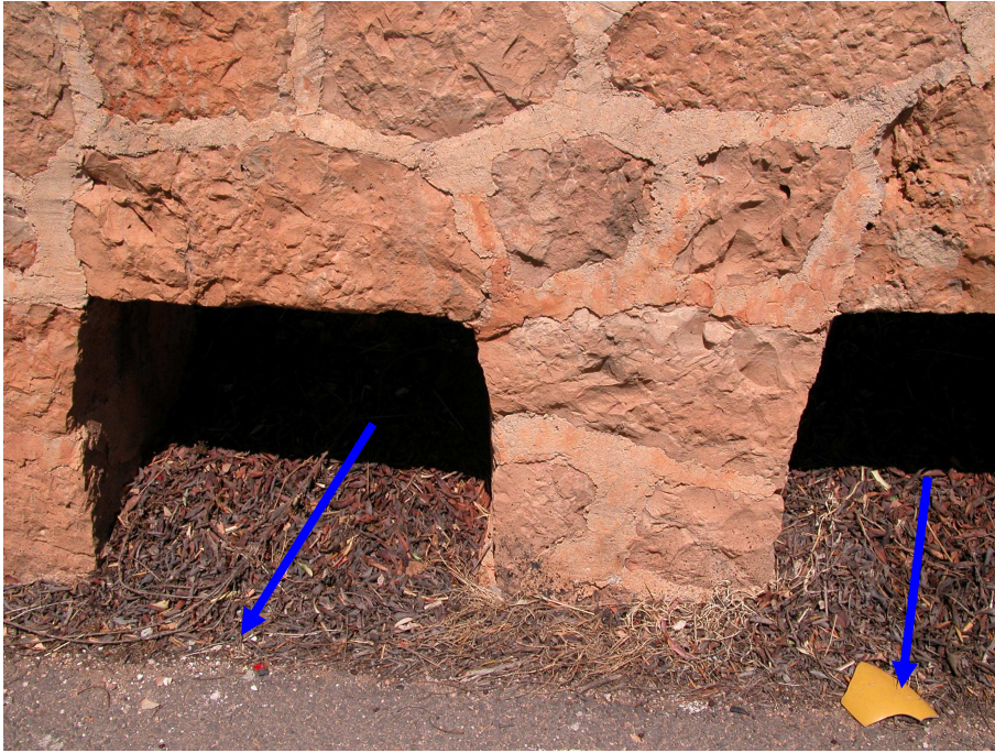
Figura 14: Espais als murs per a l'evacuació de pluvials (clavegueres) a Es Cabàs
