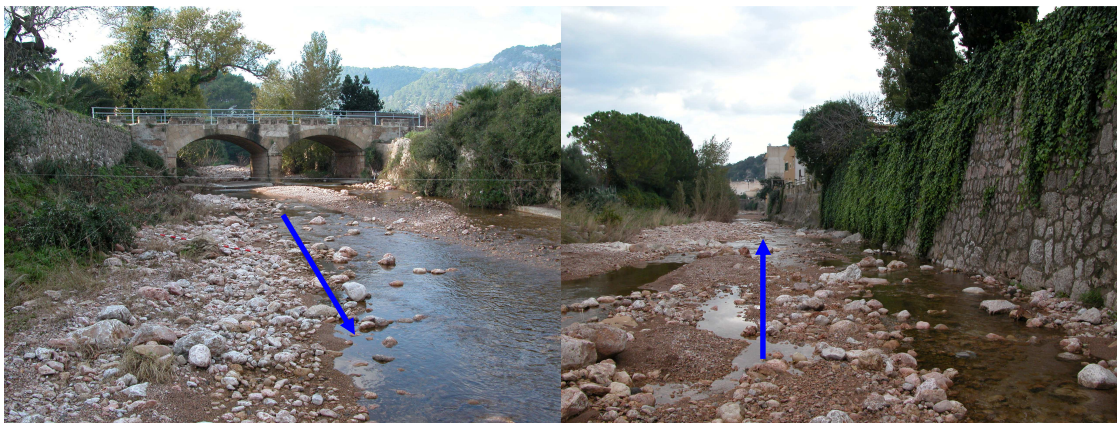
Figura 100: Pont i murs al torrent de Sant Jordi
