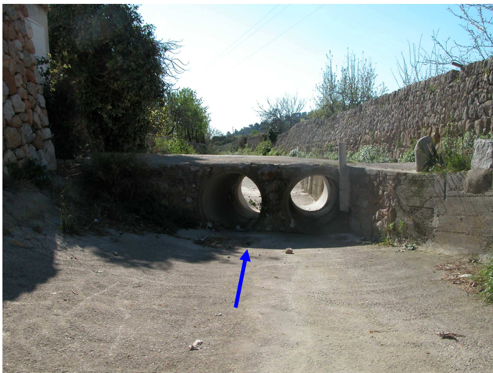
Figura 62: canalitzacions de sortida del nucli urbà del torrent d'Alaró
