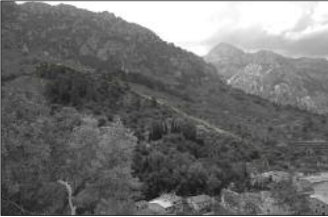
Figura 3. Ladera objeto del estudio. Situada en la margen izquierda del Torrente de Fornalutx, que deja el casco urbano en su ribera derecha. La ladera se encuentra muy vegetada debido a las medidas adoptadas después del movimiento de 1974.
