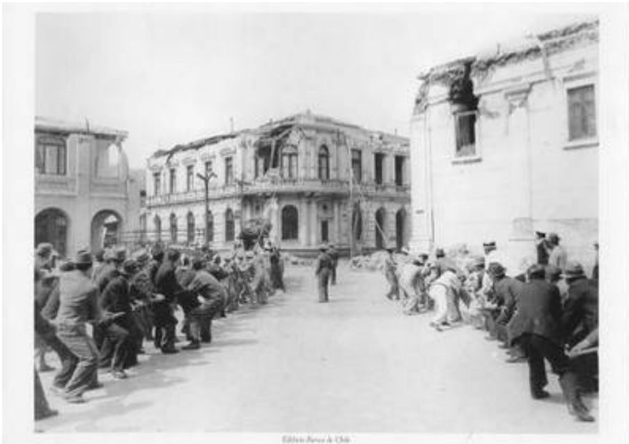
Photo 5: Témoin des travaux de démolition après le tremblement de terre de 1939 (source: Archive Universidad de Concepción).
