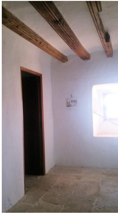
Forjat sostre planta segona (Font: Fotografia feta per l'autora de l'estudi)
