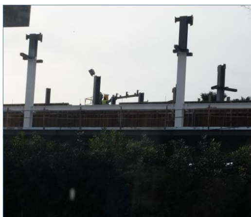
Reforma hotel Sunclub del Port de Pollença en primera línia de mar amb estructura d'acer galvanitzat.
