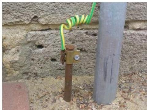
Nuestra instalación estará formada por un anillo cerrado que cubrirá todo el perímetro del edificio una vez levantado el solado existente y dos picas para entrar en contacto con el terreno.
