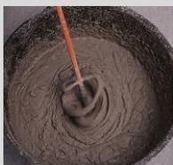
Amasar **weber.therm base** con 5,5 – 6,5 litros de agua limpia por saco, con un batidor eléctrico.
