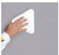
La gota obtenida con la pistola de proyección puede apretarse con paletín, triángulo de plástico, etc., para obtener el acabado gota chafada.
