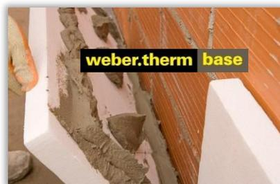
Las placas se pueden adherir mediante cordón perimetral de unos 5 cm de ancho y unos 3 cm de espesor, y tres pegotes centrales, asegurando siempre una adhesión mínima del 40% de la superficie de la placa.
