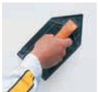
Acabado fratasado: cuando el material tenga la consistencia adecuada, dar el acabado utilizando una llana de plástico, limpiándola regularmente, haciendo suaves movimientos circulares, verticales u horizontales, en función a la textura y efecto deseado.
