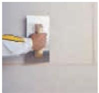
Aplicar **weber.tene stilo** con una llana de acero inoxidable en el paño de trabajo de abajo a arriba, apretando el material para regularizar el espesor de la capa. Pasar la llana vertical y horizontalmente varias veces para obtener una capa del material uniforme y sin excesos.
