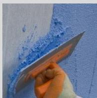
3. Una vez seca la regularización, proceder al acabado mediante la aplicación de un revestimiento acrílico de la **gama weber.tene**, previa aplicación de la imprimación **weber CS**.
