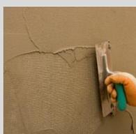
2. Una vez colocadas las placas, seco el adhesivo y ancladas mecánicamente con un mínimo de 6 espigas por cada m<sup>2</sup>, regularizar las placas con una capa de 5 a 6 mm armada con **weber.therm malla 160**.
