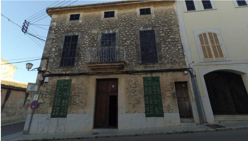
Façana principal de paret verda sense revestiment
