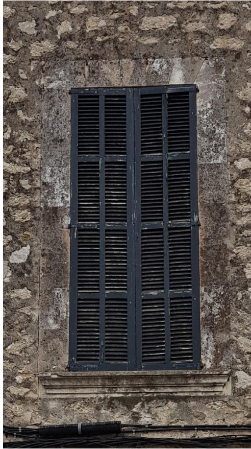
Finestra primer pis, façana principal.
