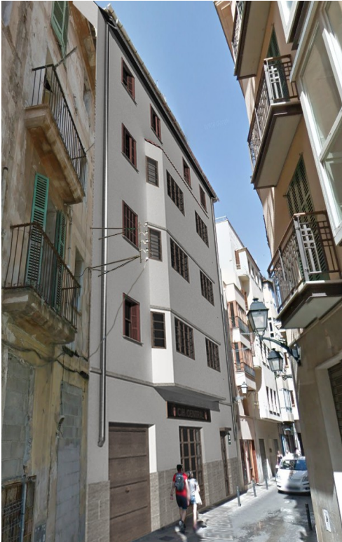
Vista de fachada desde laterales
