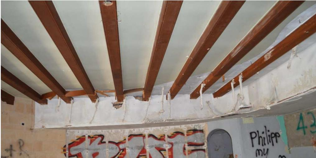
**Figura 23: Forjado Viguetas Madera Bar**
