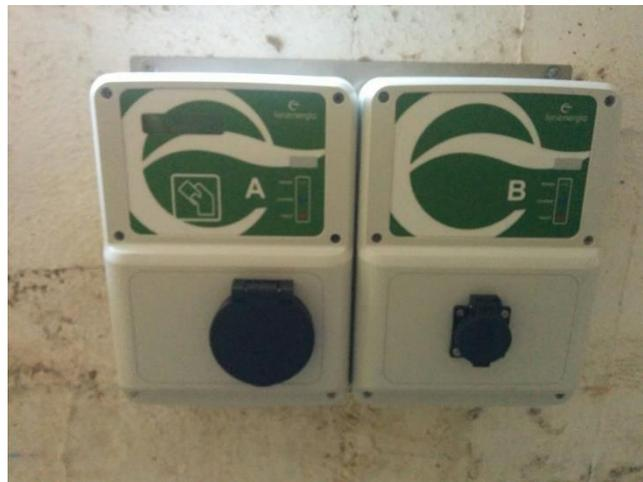
Ilustración 72 Circutor RVE-WB-MIX-Smart-Tri
