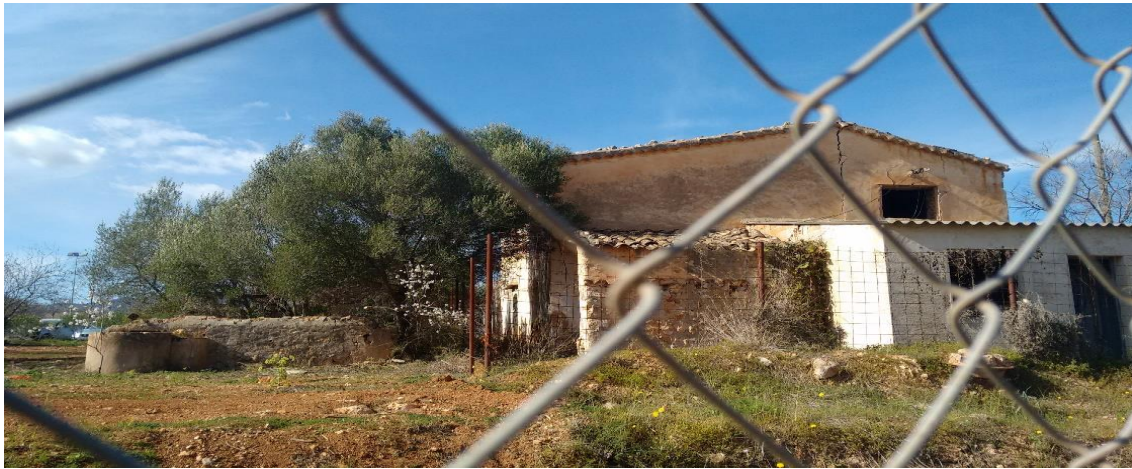
Imagen 7. Ca Ses Llúcies 2 Se distingue la caseta de aperos anexa al cuerpo principal y el vallado perimetral alrededor de la edificación
