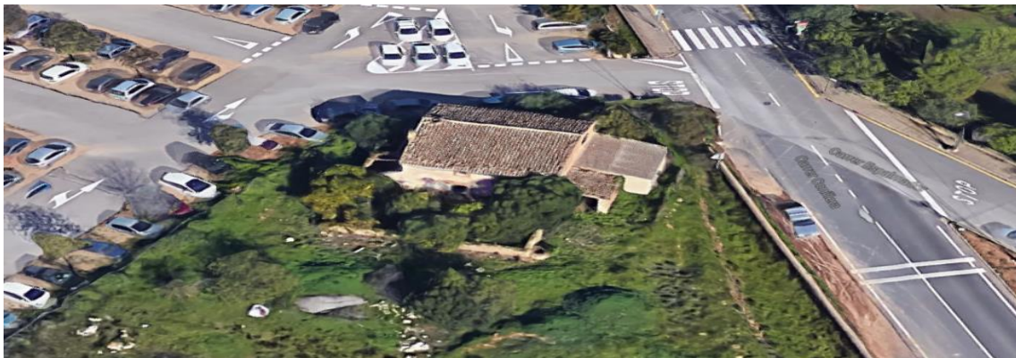
Imagen 5. Google Maps. Edificio Ca ses Llúcies.
