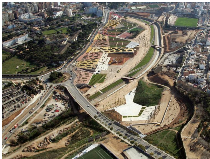
Ilustración 2: Intervención de Ravetllat Ribas Arquitectos (2007)
