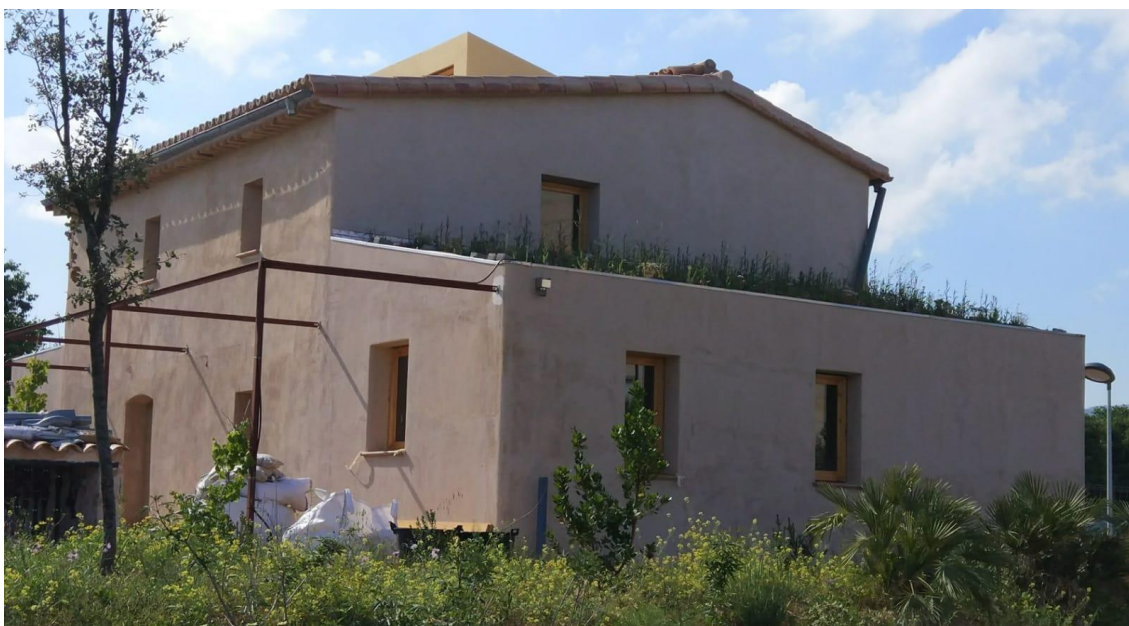
Fig 8. Edifici Ca ses Llúcies en construcció
