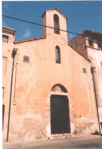
Ilustración 6: Aspecto de la fachada antes de su rehabilitación. Fuente: Catálogo PGOU Palma.
