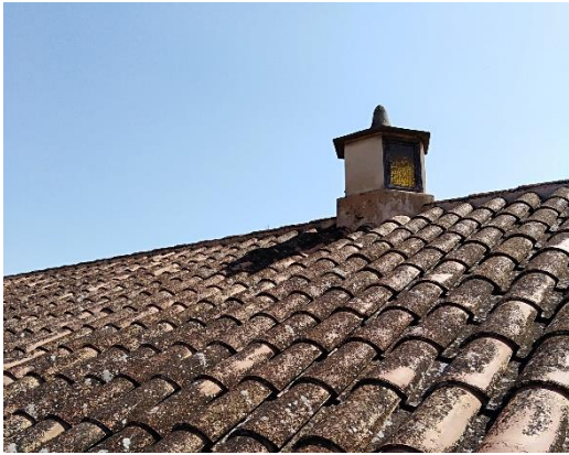
Ilustración 30: Detalle de la linterna.
