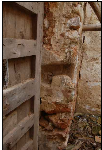
4.9. ELEMENT A CONSERVAR: TRAVADOR
