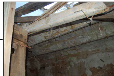
1.2. ELEMENT A RETIRAR: FORJAT DE BIGUETES PRETENSADAES
