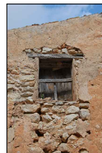
2.8.TIPOLOGIA A CONSERVAR: REIXAT DE FUSTA
