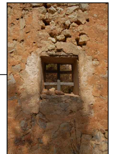
2.8.TIPOLOGIA A CONSERVAR: REIXAT DE FUSTA
