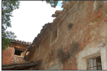
2.6. ELEMENT A CONSERVAR: CORNISA
