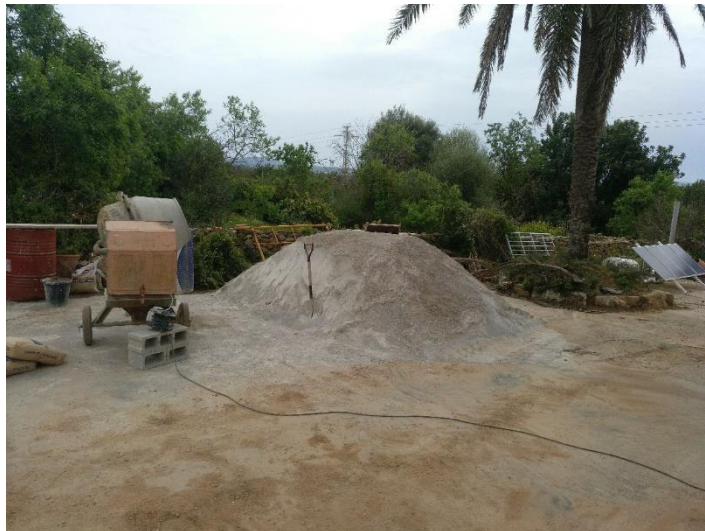
Zona de acopio de áridos y preparación de morteros.
