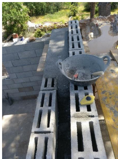
6 – Vista superior del recrecido del muro entre la zona existente y la zona de ampliación, además del dintel de la nueva abertura entre ambas zonas.
