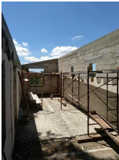
4 – Vista de la estructura de la planta piso.
