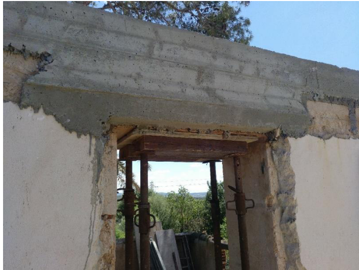
3 – Detalle del dintel de la balconera de acceso a la planta piso desde la terraza.
