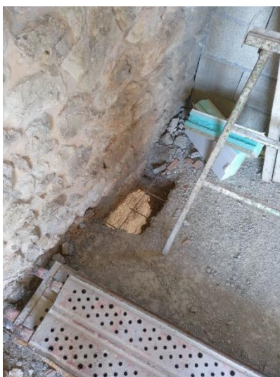
Vista del hueco de paso de instalaciones en el suelo de la planta piso.
