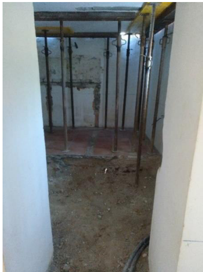
Detalle de los puntales colocados bajo el forjado de techo de la planta baja, en la zona de la cocina actual.
