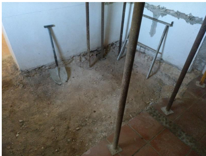
3 – Demolición del pavimento interior de la planta baja del Edificio Principal, en la zona de la cocina existente.
