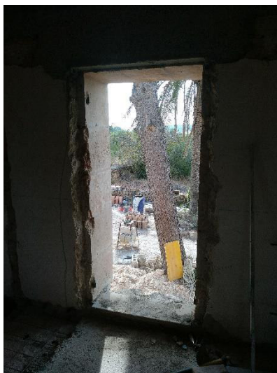
Vista de la balconera de la fachada Sureste (fachada principal).
