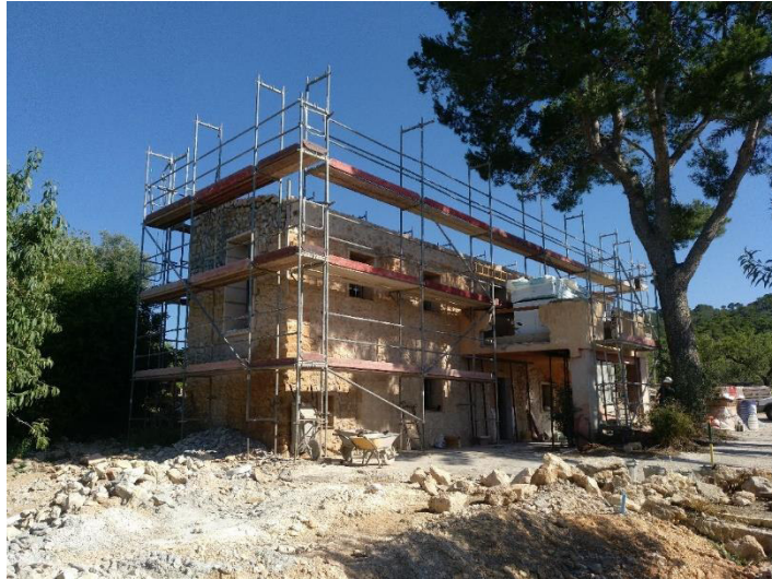
2 – Vista general del Edificio Principal (Fachadas Suroeste y Sureste) junto con el andamio perimetral.
