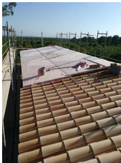
4 – Cubierta de la zona de ampliación con cobertura de teja cerámica y cubierta de la zona existente con la lámina impermeabilizante.
