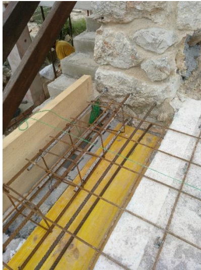
4 – Detalle del empotramiento de las barras longitudinales en el muro de carga de mampostería, sellado con resinas epoxi.
