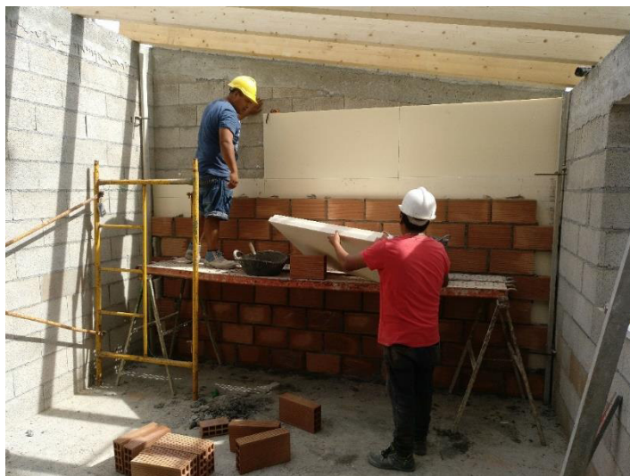
7 – Colocación del aislamiento térmico y realización del trasdosado en la fachada Noreste.
