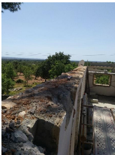
Detalle de la diferencia de cota entre la plataforma situada sobre andamio tradicional.
