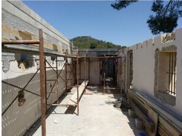
4 – Vista de la planta piso con la disposición de los andamios tradicionales.
