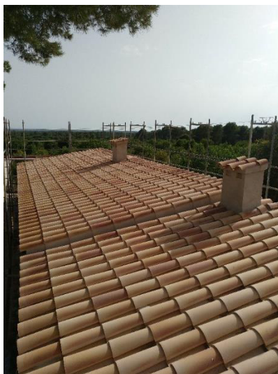
4 – Cubierta del edificio.
