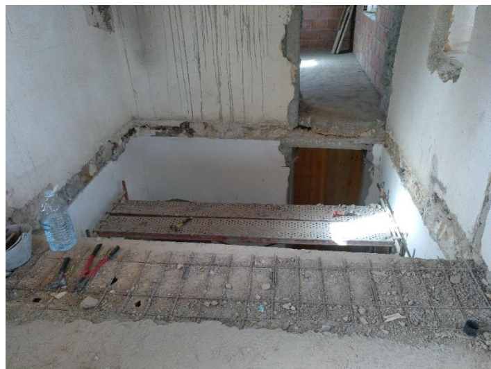
7 – Demolición del forjado de techo de la planta baja para nuevo hueco de escalera interior.
