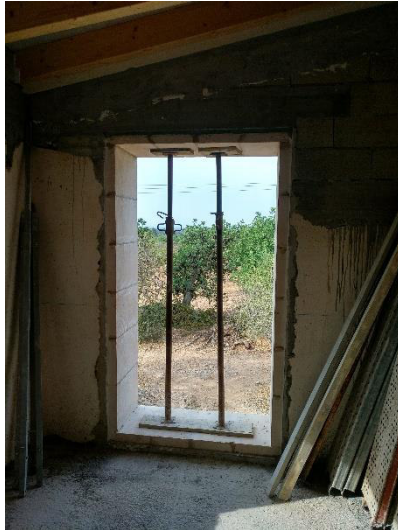
Vista de la balconera de la fachada Suroeste.
