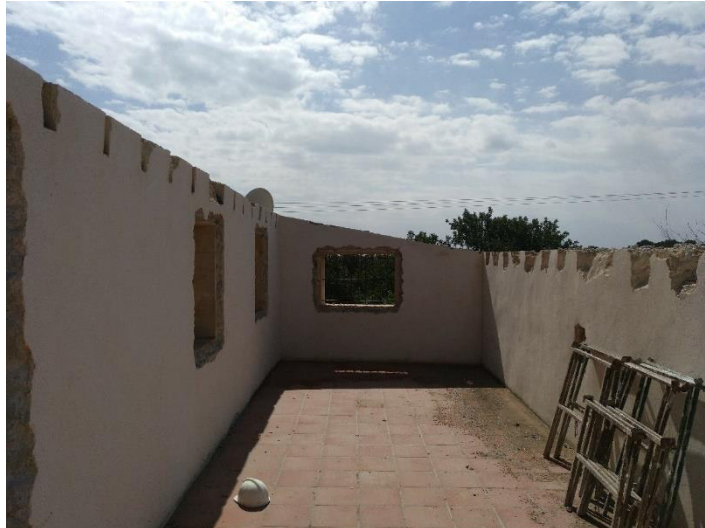
4 – Planta piso una vez finalizada la demolición de la cubierta.
