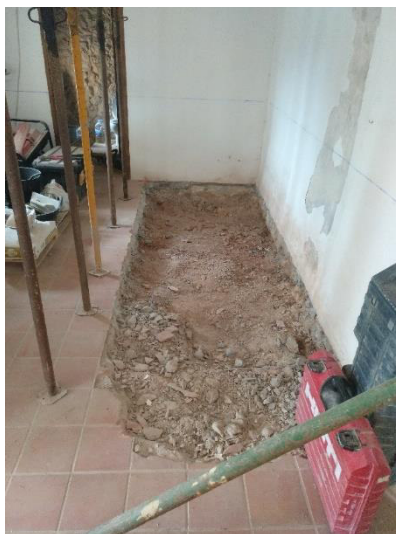
4 – Continuación de la demolición del pavimento de la planta baja y vaciado hasta la cota prevista en proyecto.
