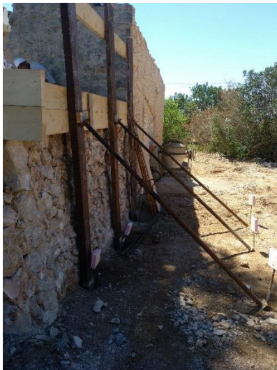
Detalle del encofrado de los zunchos de borde y la viga en la zona de la terraza lateral en planta piso.
