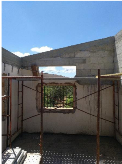
6 – Detalle de la ventana situada en la Fachada Sureste, con el dintel existente y el definitivo.
