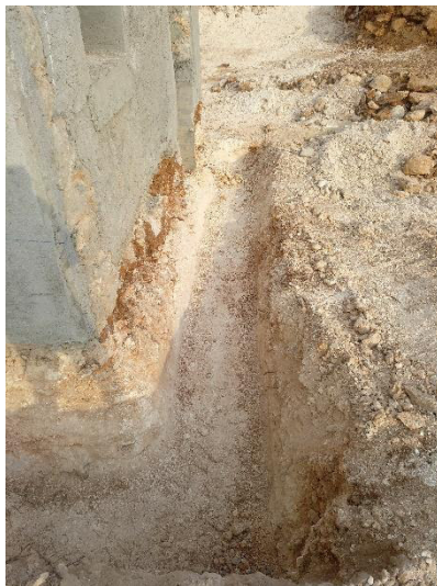
6 – Detalle de la zanja perimetral en la fachada Noreste.
