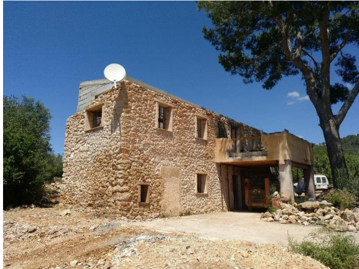
2 – Vista general del Edificio Principal (Fachadas Suroeste y Sureste).
