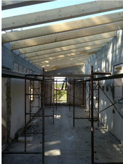
5 – Planta piso del edificio, con las vigas de madera laminada colocadas y preparadas para recibir el panel sándwich.
