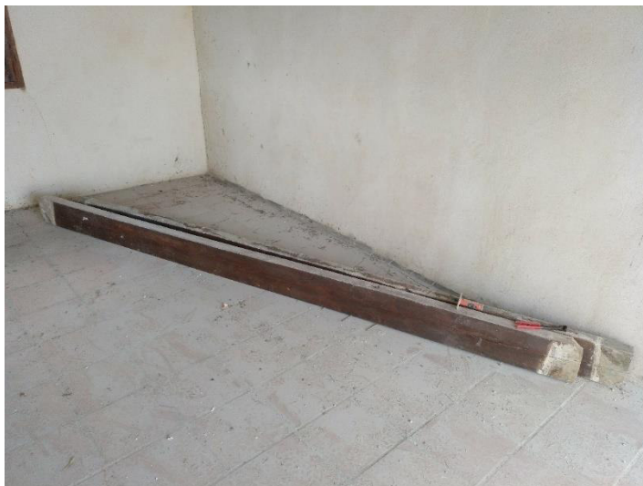
3 – Vigas retiradas de la estructura de la cubierta del edificio.
