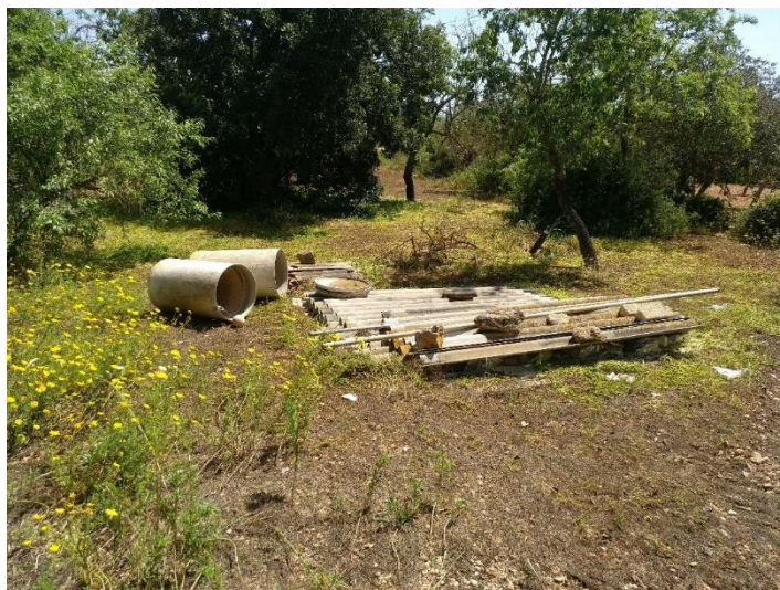
3 – Zona de acopio de elementos con fibrocemento (placas onduladas y depósitos).
