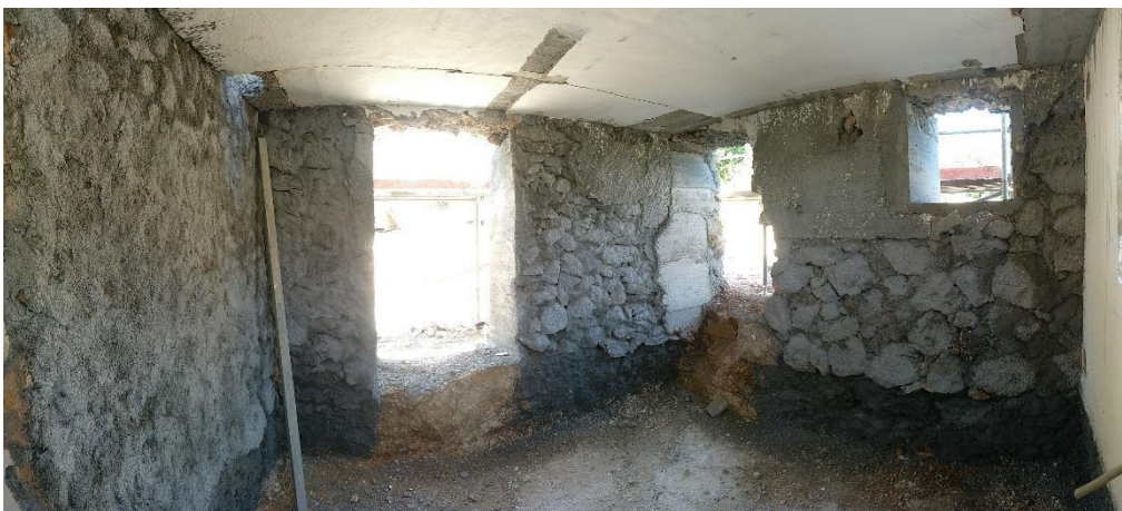
6 – interior del edificio en planta baja en la zona del baño y coladuría-tendedero.
