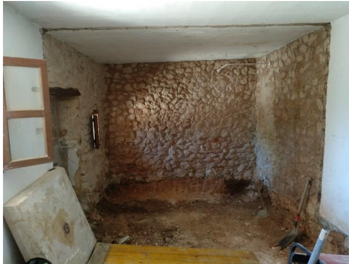
5 – Vista del interior del edificio en planta baja en la zona del dormitorio doble principal.
