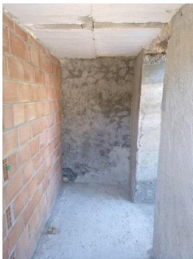
7 – Coladuría-Tendedero, vista desde la nueva balconera en la fachada Noreste.
