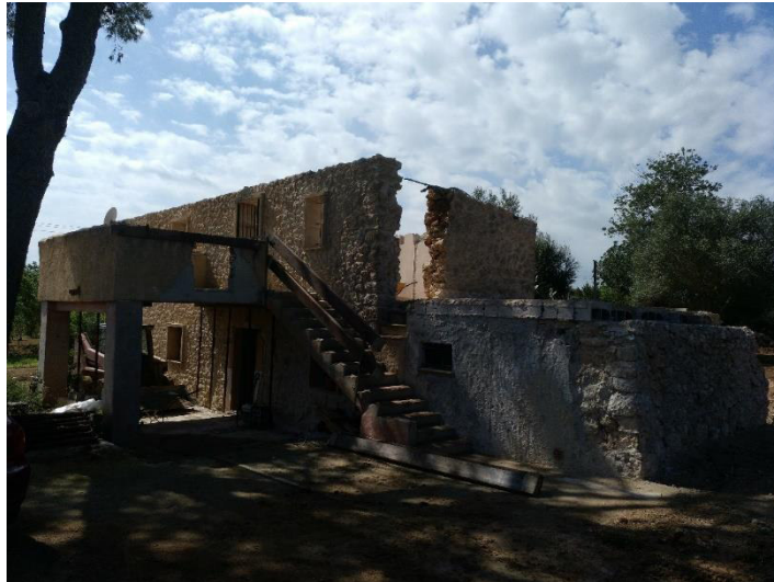
2 – Vista general del Edificio Principal (Fachadas Sureste y Noreste)
