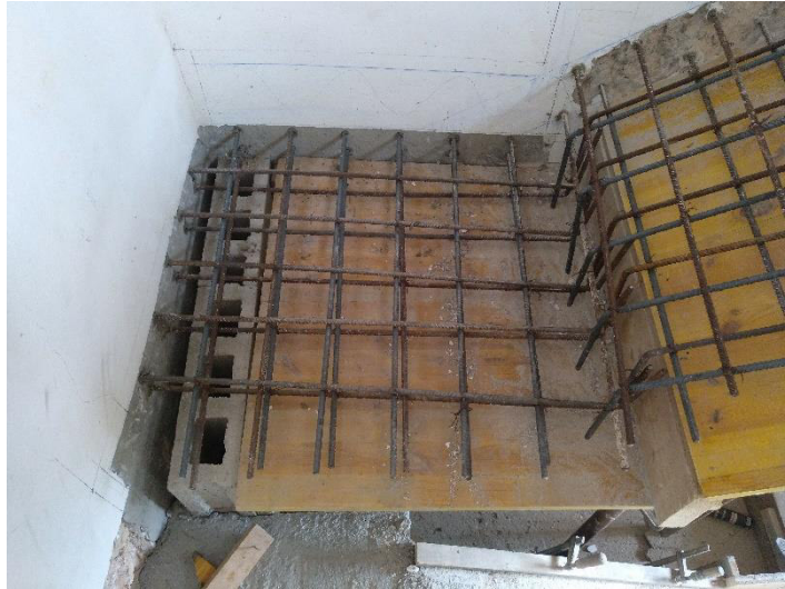
2 – Detalle del encofrado y armado del rellano de la losa de escalera.
