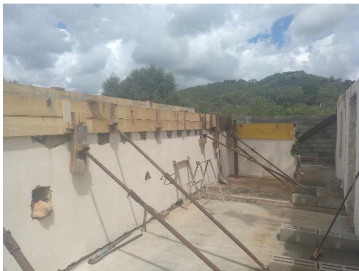
3 – Vista de la planta piso con el encofrado del zuncho de apoyo del nuevo muro de carga.
