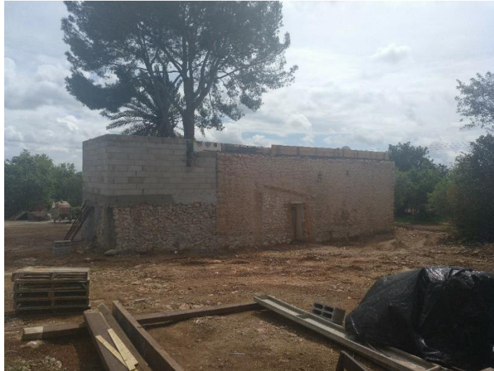
1 – Vista general del Edificio Principal (Fachadas Noroeste y Noreste).
