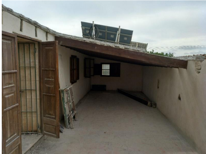
4 – Demolición de la cubierta del Edificio Principal. Cubierta de teja de hormigón vibrado sobre entrecigado de piezas de marés i capa de compresión de hormigón armado.
