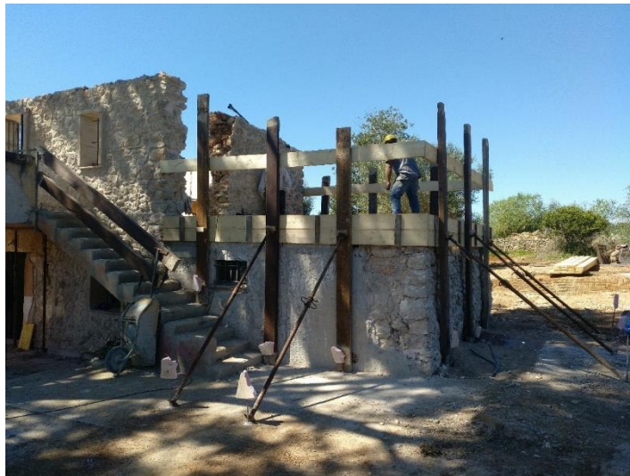
2 – Encofrado de los zunchos y viga del forjado de techo de la planta baja en la zona de la terraza lateral (Fachadas Sureste y Noreste).
