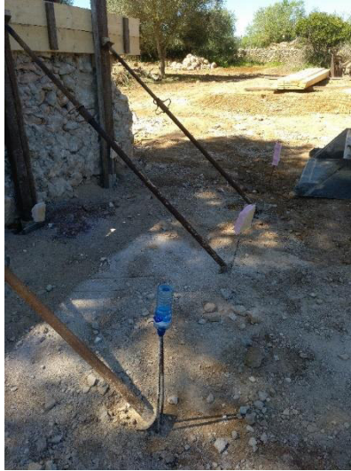
Detalle de la se3alizaci3n de las barras clavadas al terreno.
