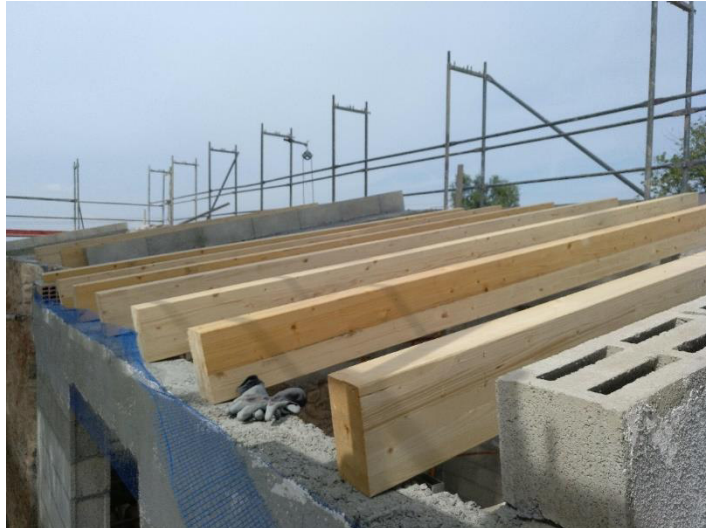
8 – Colocación provisional de las vigas de madera laminada en la zona de ampliación.
