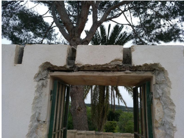
3 – Detalle del dintel de la balconera de acceso a la planta piso, objeto de demolición y reconstrucción junto con el zuncho de coronación de la nueva cubierta.
