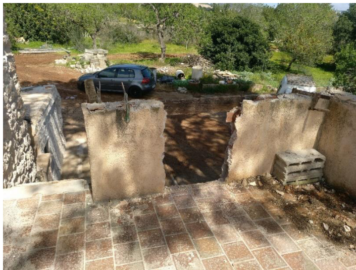
Hueco realizado en el antepecho de fábrica en la terraza de acceso a la planta piso.
