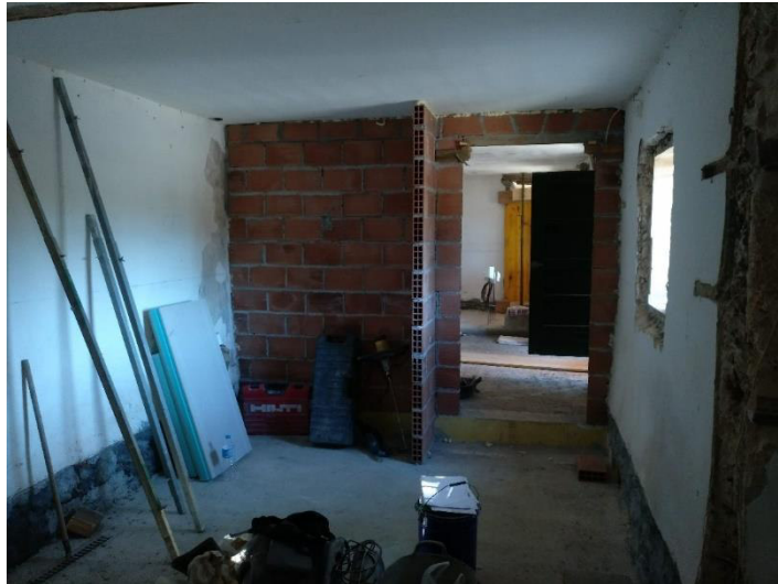
6 – Interior del edificio en planta baja. Separación entre el dormitorio doble principal y la entrada a la vivienda.
