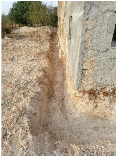
5 – Detalle de la zanja perimetral en la fachada Sureste (fachada principal).
