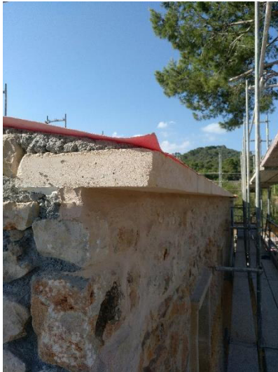
6 – Detalle del alero de marés.
