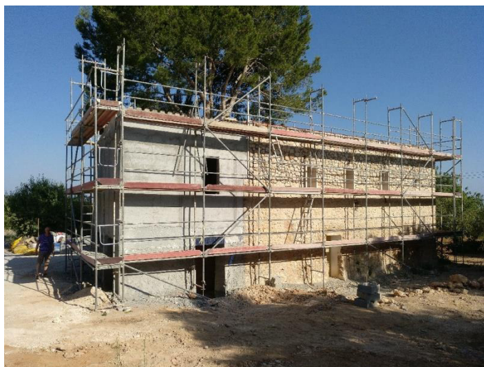
1 – Vista general del Edificio Principal (Fachadas Noroeste y Noreste) junto con el andamio perimetral.
