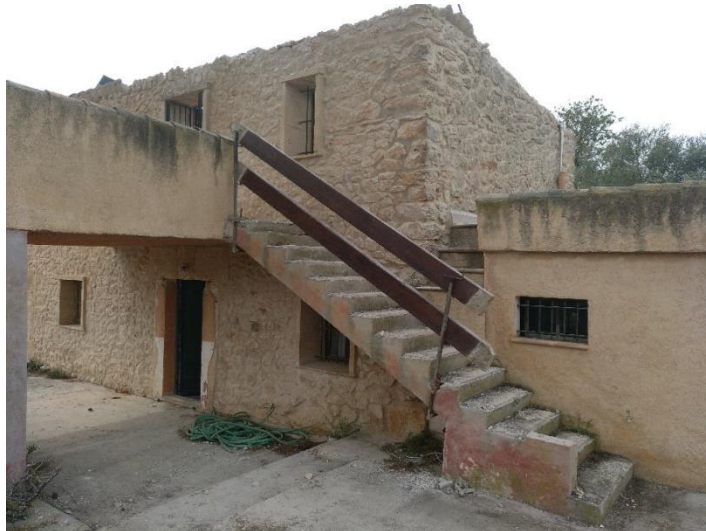
Detalle de la barandilla situada en la escalera exterior existente de acceso a la planta piso
