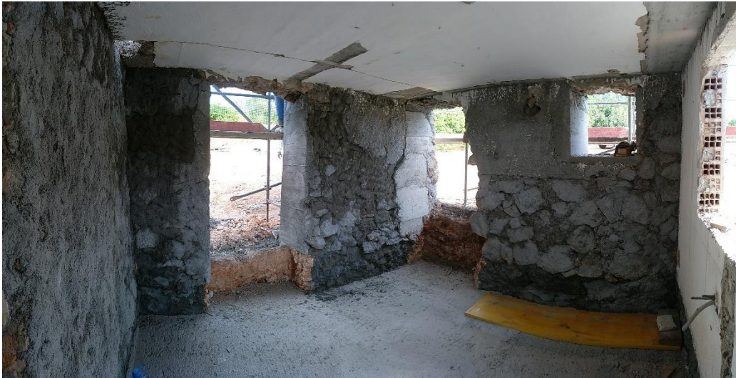
6 – interior del edificio en planta baja en la zona del baño y coladuría-tendedero con la nueva solera realizada.
