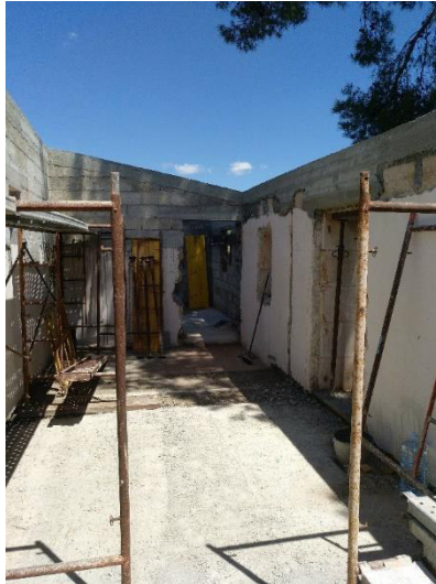
5 – Vista de la estructura de la planta piso.
