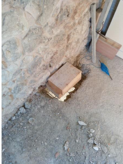
Vista del hueco de paso de instalaciones en el suelo de la planta piso, cubierto con dos tablones de madera.
