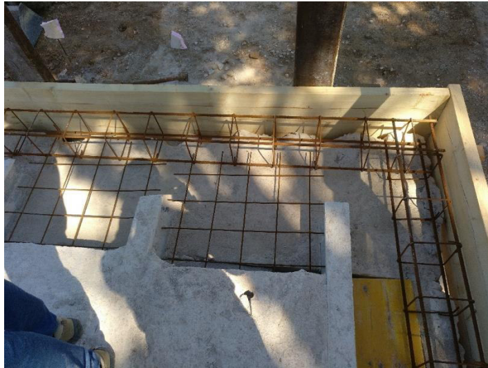
5 – Encuentro del armado ente zuncho de borde y viga de apoyo sobre el muro de carga de mampostería.
