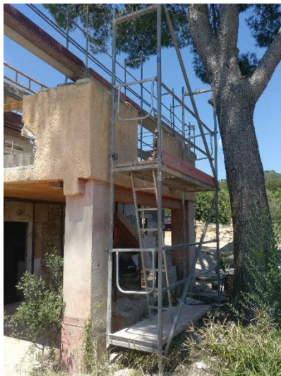
3 – Módulo de andamio para acceso a la planta piso.
