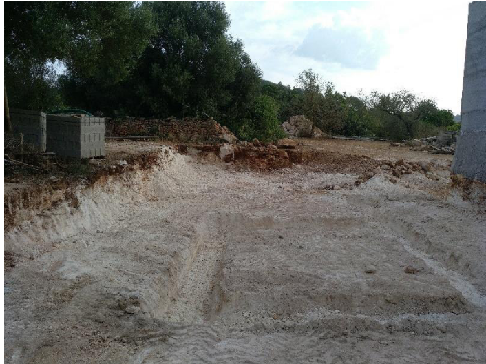
4 – Detalle de la zona de excavación en la zona de ampliación de planta baja.
