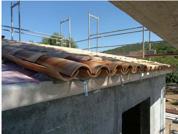
3 – Detalle del alero de la cubierta de la zona de ampliación de planta piso, con los soportes para la canal de recogida de agua pluvial.
