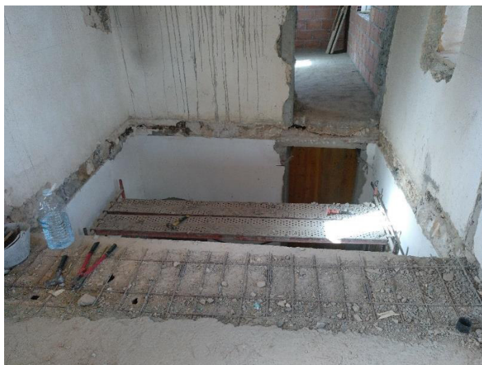
Vista del hueco de escalera realizado tras la demolición del forjado de techo de la planta baja.
