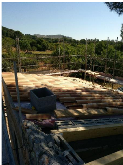
4 – Cubierta de la zona de ampliación de planta piso, con la salida de humos.
