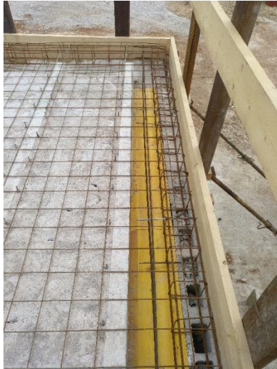
3 – Armado del zuncho de borde más las barras longitudinales extra entre los estribos y la primera vigueta.
