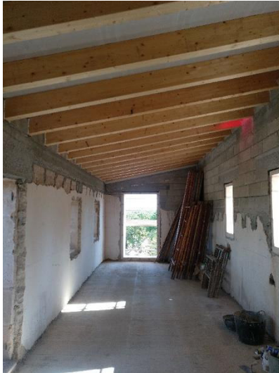
5 – Planta piso del edificio, en la zona existente con la cubierta finalizada.
