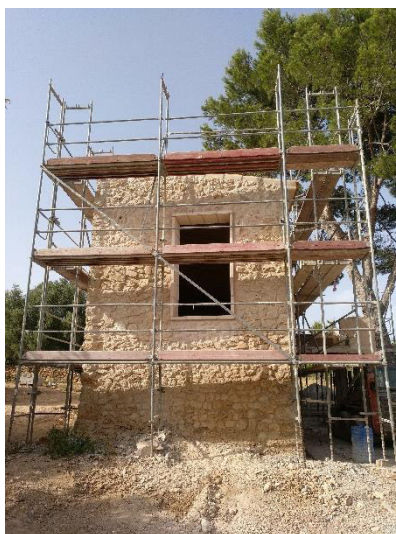
Vista de la fachada Suroeste con la balconera y el andamio perimetral.
