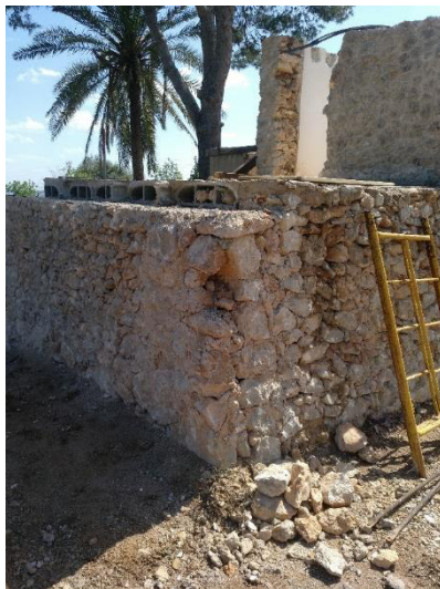
3 – Detalle del estado del muro de mampostería de la fachada Noreste, y del apoyo de las viguetas y de las bovedillas sobre dicho muro de carga.
