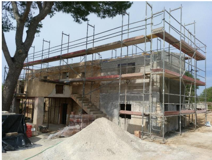
3 – Vista general del Edificio Principal (Fachadas Noreste y Sureste) junto con el andamio perimetral y la zona de acopio de materiales y preparación de morteros.
