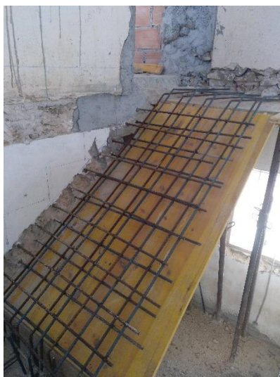
1 – Detalle del encofrado y del armado de la losa de escalera.
