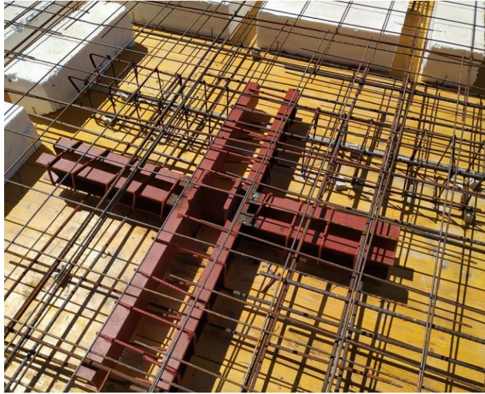
Figura 54. Ejemplo de cruceta metálica de punzonamiento.
