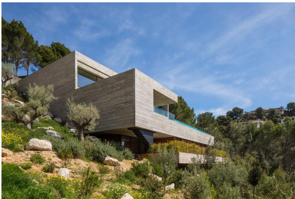
Figura 6. Proyecto con elementos de hormigón visto. Osvaldo Luppi Architects.
