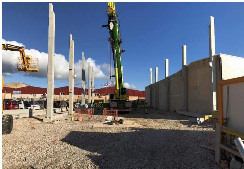
Figura 4. Ejecución de estructura con elementos prefabricados en Pol. Son Bugadelles (Calvià).
