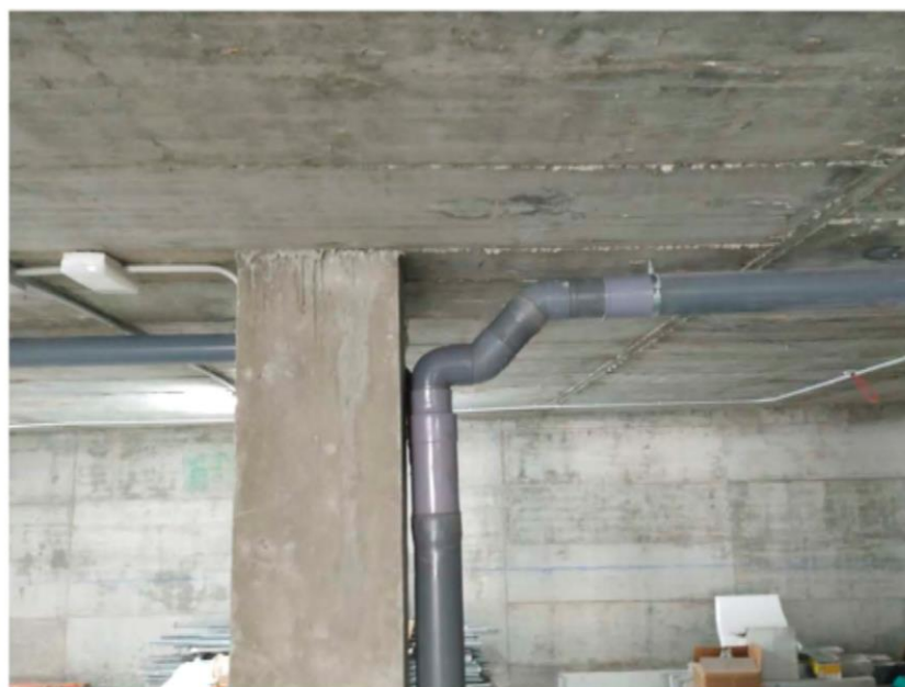
Solució a pluvial al parking per deixar pasa al tub de la CGP al comptador
