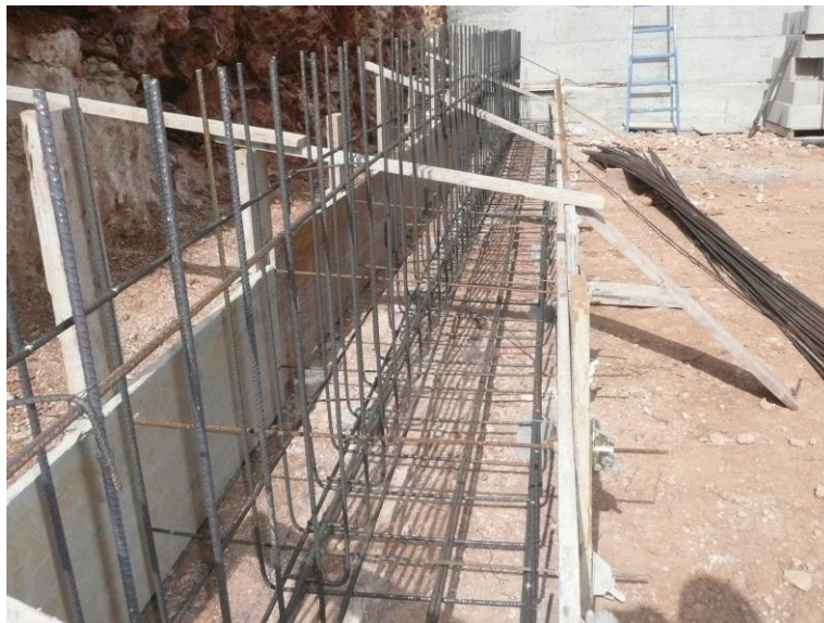
Execució de sabates continua del mur de contenció a una cara:
