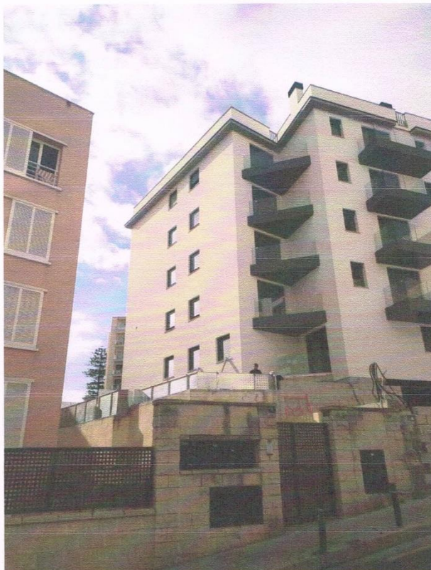
FOTOGRAFIA FACHADAS EDIFICIO DE 19 VIVIENDAS Y APARCAMIENTOS, C/ Son Catlaret 3, C/ Pedrera 6 Palma
