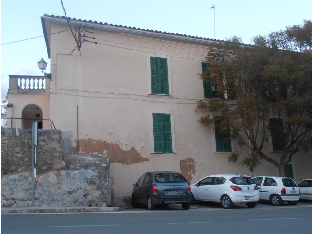
Salvo esos detalles, el edificio se encuentra en un estado de conservación muy bueno, los cerramientos exteriores tienen un gran espesor (63,5 cm) y actúan como muros de carga.
