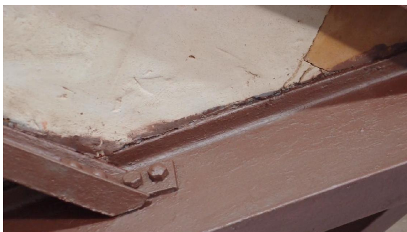
Imagen 1.4.26: Imagen de la unión de los elementos de la cercha mediante pernos.
