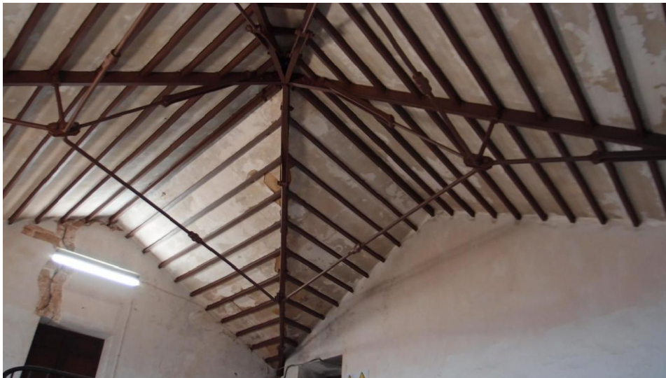
Imagen 1.4.28: Entramado de cerchas en la cubierta del núcleo de la escalera que da acceso a la zona a rehabilitar.
