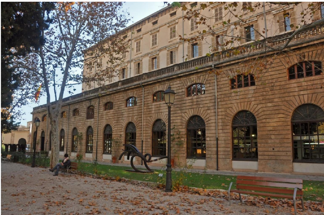
Imagen 1.1.3: Fachada del "Departamento de hombres".
