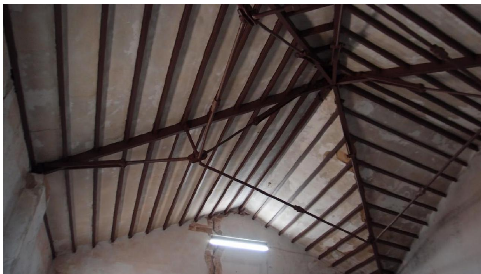
Imagen 1.4.5: Vista general del acceso a la planta.
