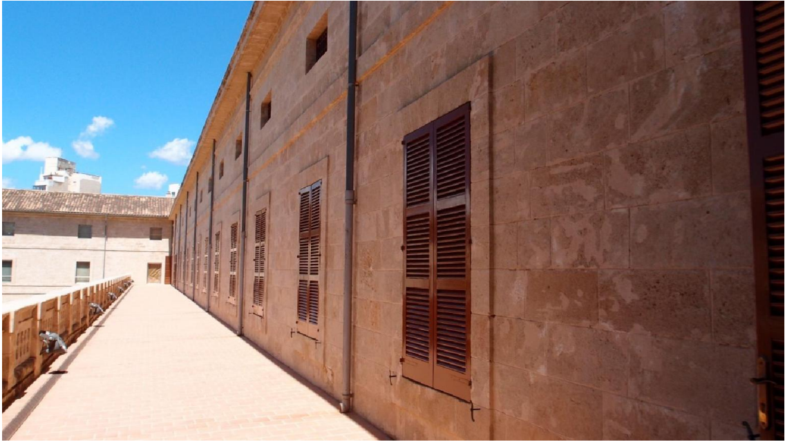
Imagen 1.4.31: Vista de la fachada que da al 'Pati del Homes' en el que no se aprecia ningún síntoma de lesión por humedades o por filtraciones debido a trabajos de mantenimiento de fachadas en el exterior.
