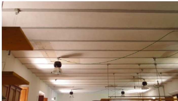
Imagen 1.4.14: Vista general de la sala que hay en el nivel inferior a la zona de rehabilitación. Se puede ver el forjado techo planta segunda compuesto de viguetas metálicas y bovedillas curvas.
