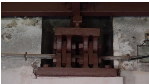
Imagen 1.4.9: Vista frontal del apoyo de la cercha sobre la pilastra de marés.
