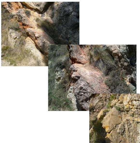
Imagen 3.4. Brecha de falla.
