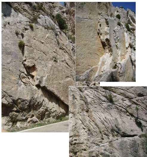
Imagen 11.5. Estratos paralelos que forman el flanco del pliegue de eje vertical. La fotografía de la parte inferior muestra en detalle las grietas de descompresión.
