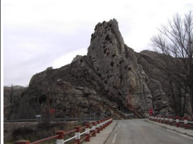
Imagen 3.1. Vista general de una falla.
