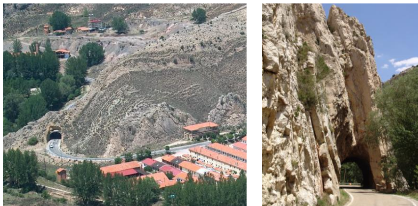
Imagen 13.1. Túneles para la construcción de la carretera.
