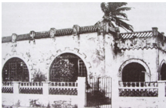
Casa campamento en Boca del Río (Archivo privado de Arsenio García).
