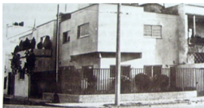
Calle Klepler, 26 – Esquina con Calle Copérnico (Archivo privado de Arsenio García).
