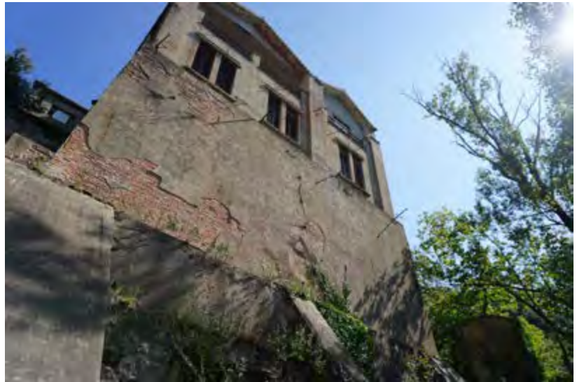
Vista exterior dels vestigis de l'edifici operatiu de la Mina Canta. ENRS
