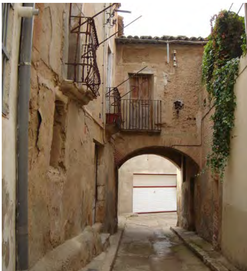
Carrer de Linyola (Pla d'Urgell), amb una casa construïda amb tàpia de principis del segle XIX. Autora: Adriana Salvat Torregossa.
