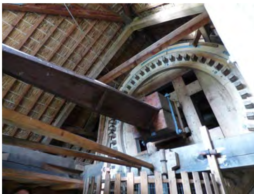
Interior del molí De Kathamer. S'hi observa la maquinària i la coberta vegetal, la qual s'ha de reposar periòdicament. DANIEL SOLÉ LLADÓS
