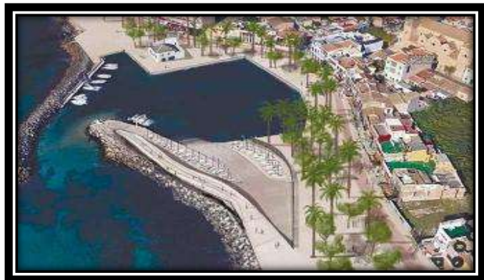
Imatge del Club Marítim una vegada hagin finalitzat les obres
